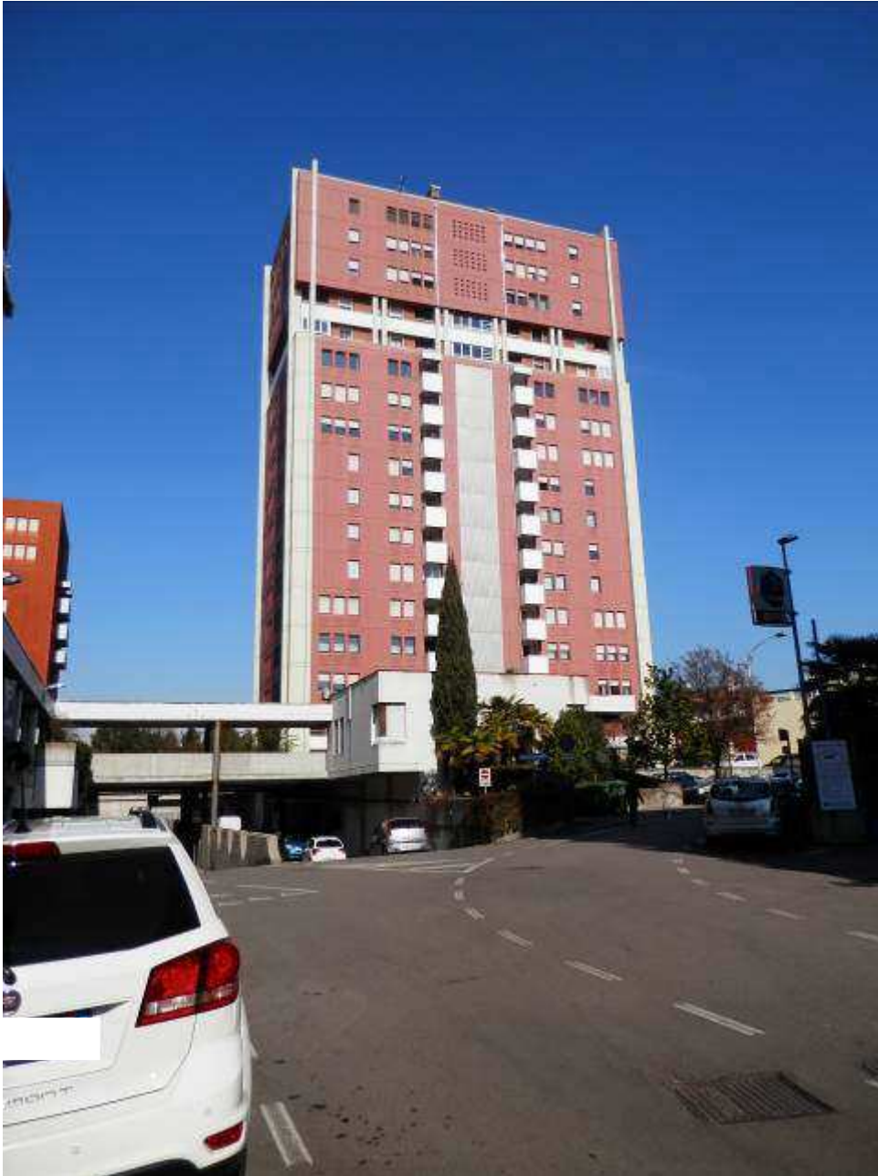
Foto 2: Fabbricato condominiale lato Sud.
