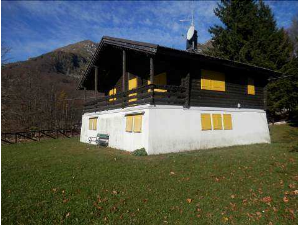
Foto 3-4: Fabbricato di abitazione lato Sud-Est.
