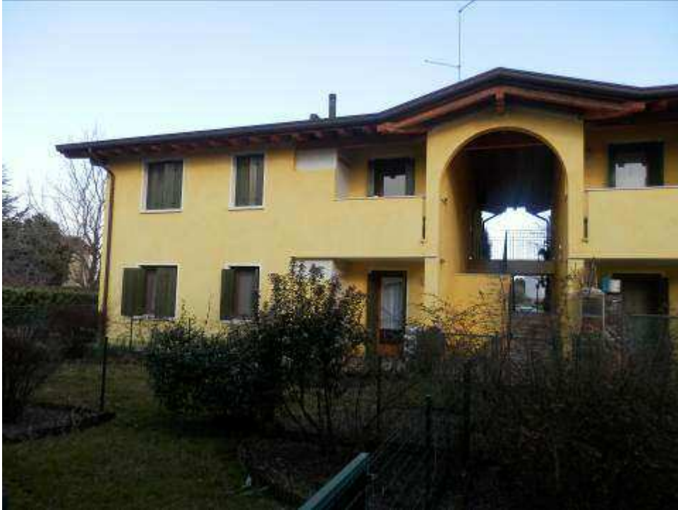
Foto 5-6: Fabbricato condominiale particolare lato Nord.
