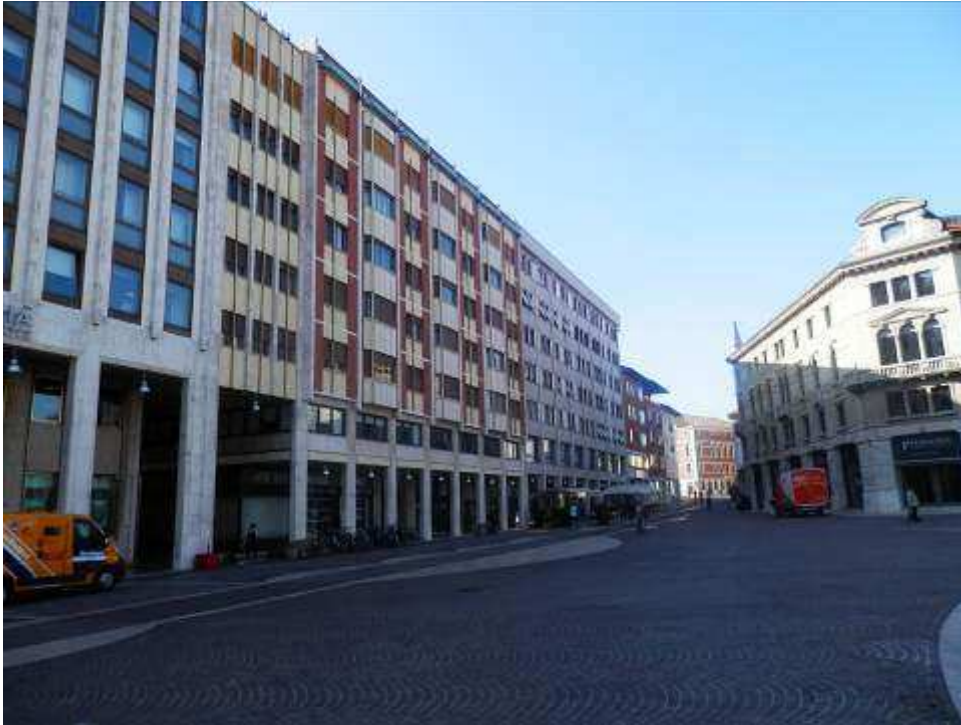
Foto 1-2: Fabbricato condominiale lato Est.
