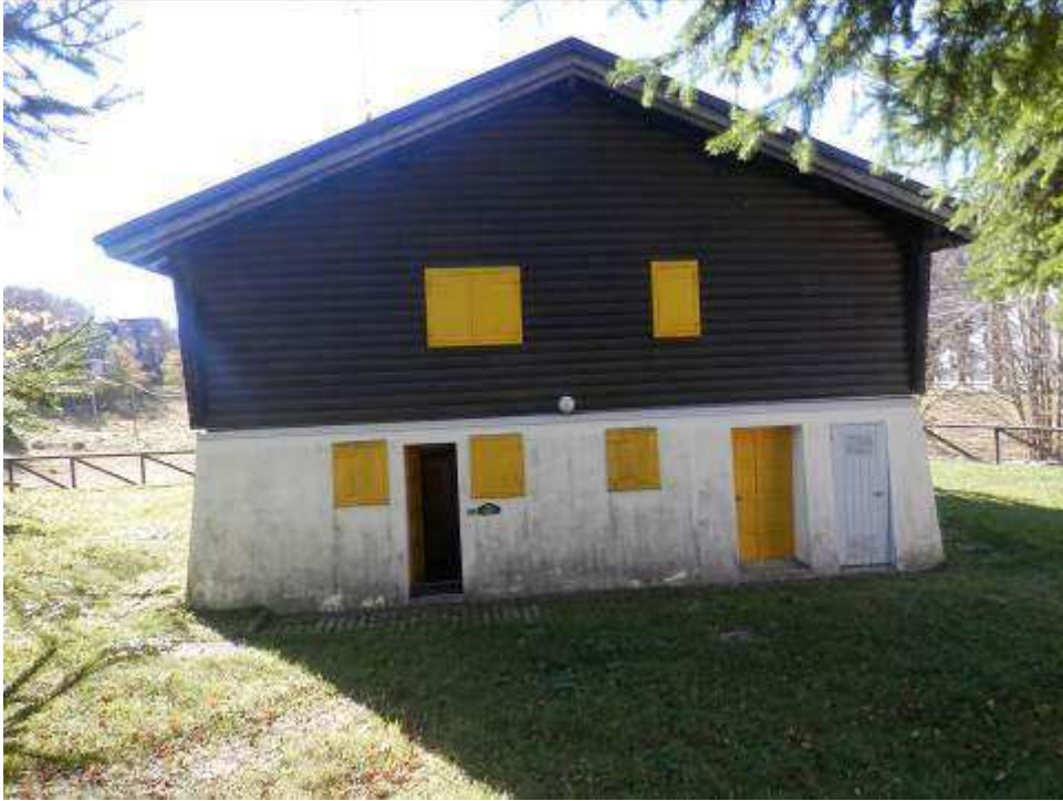
Foto 1-2: Fabbricato di abitazione lato Nord-Sud.
