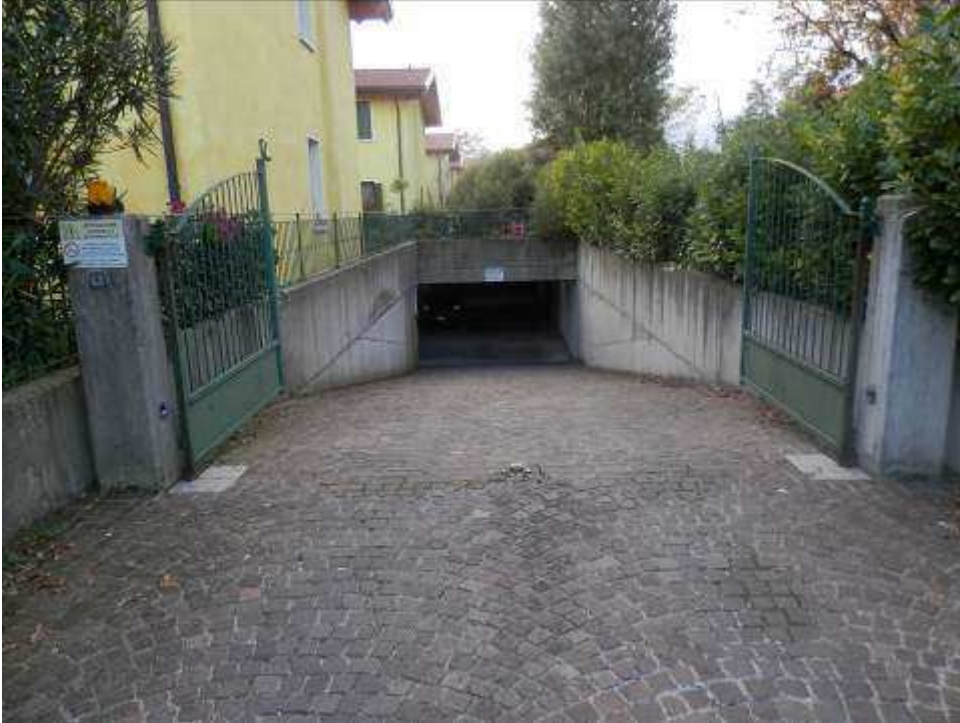
Foto 9-10: Accesso garages e interno piano interrato.
