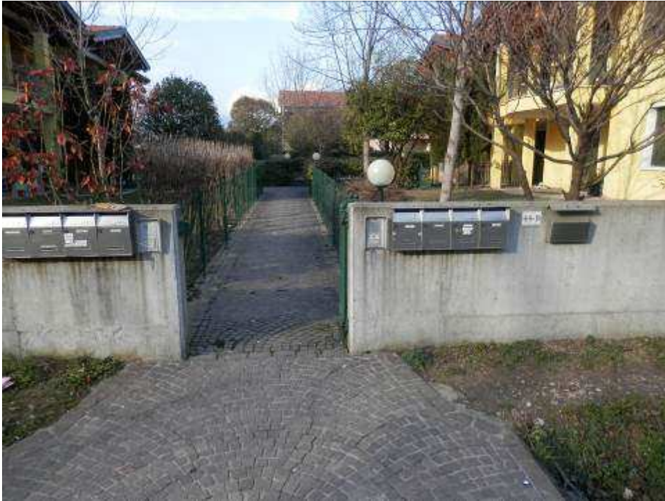
Foto 7-8: Ingresso fabbricati civ. 44/B.
