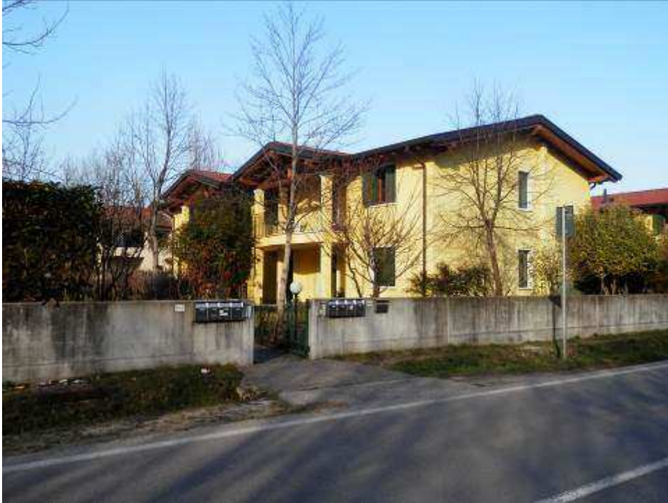
Foto 3-4: Fabbricato condominiale lato Nord-Ovest civ. 44/A.
