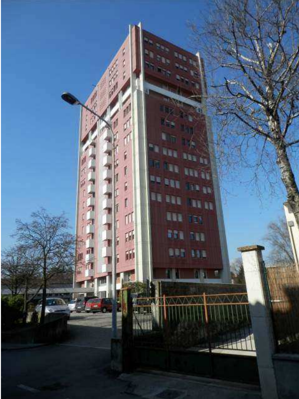
Foto 1: Fabbricato condominiale lato Sud - Est.
