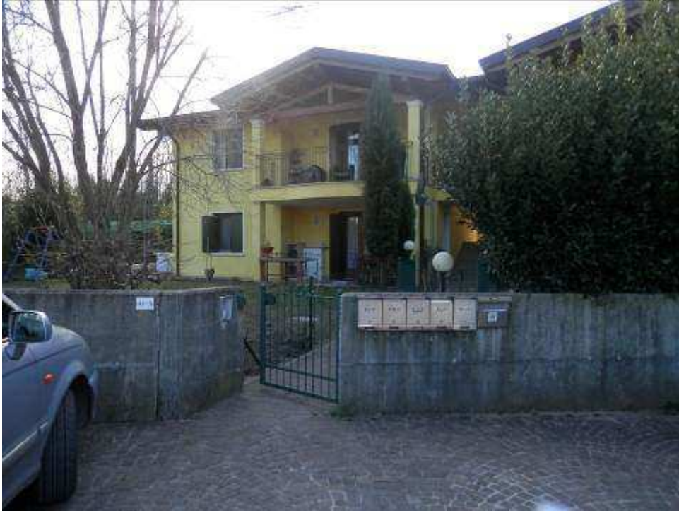
Foto 1-2: Fabbricato condominiale ingresso civ. 44/A.
