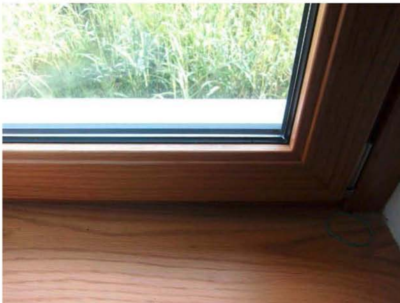
FOTO 24: PARTICOLARE VETRO-CAMERA FINESTRA
