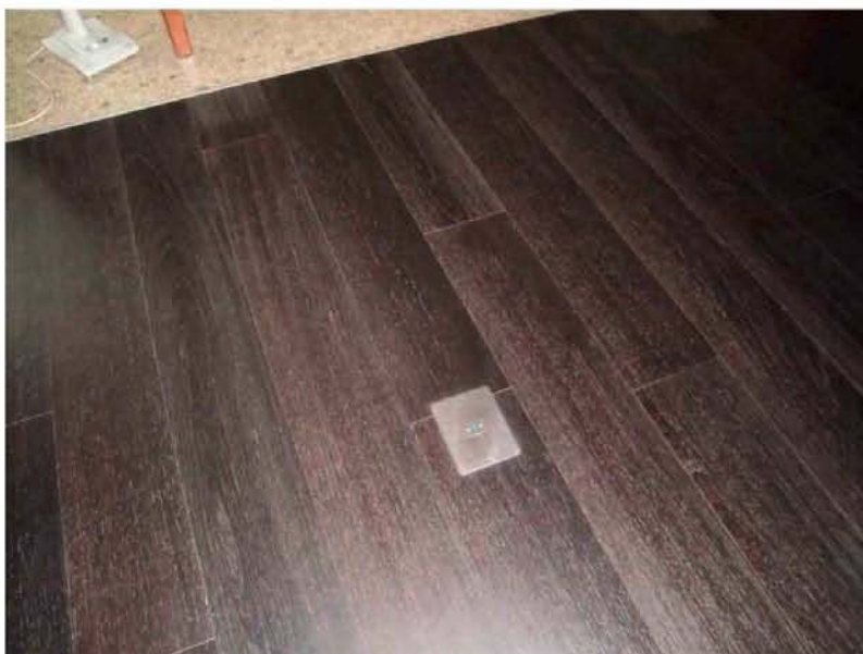
FOTO 21: PRESA ELETTRICA A TERRA ZONA GIORNO
