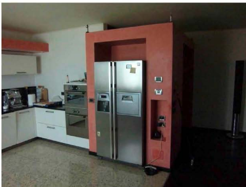
FOTO 17: STRUTTURA IN CARTONGESSO
