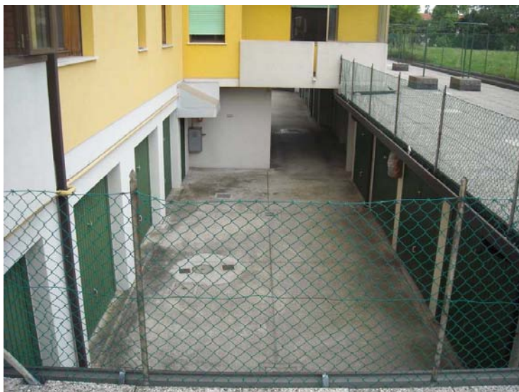
Foto 9,10 e 11 scoperto condominiale lato ovest
