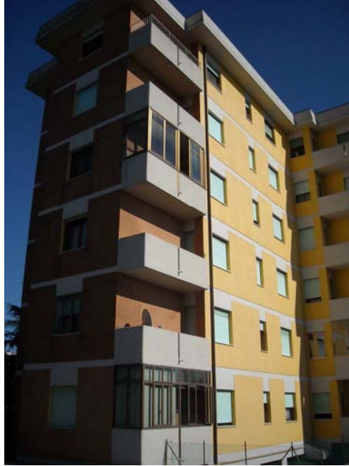
Foto 1,2 e 3 lato est ed ovest del condominio
