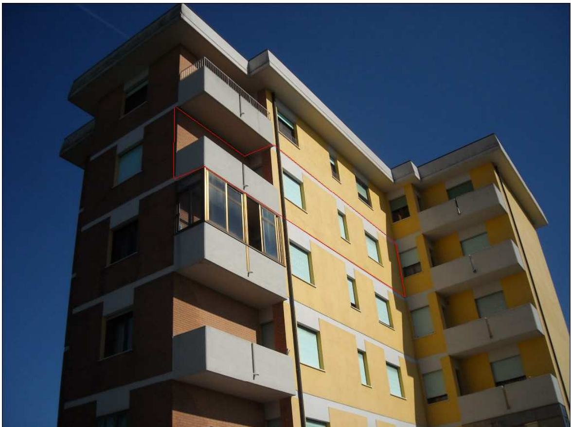
Foto 4 e 5, lato ovest con evidenziata la porzione riguardante l'immobile di che trattasi
