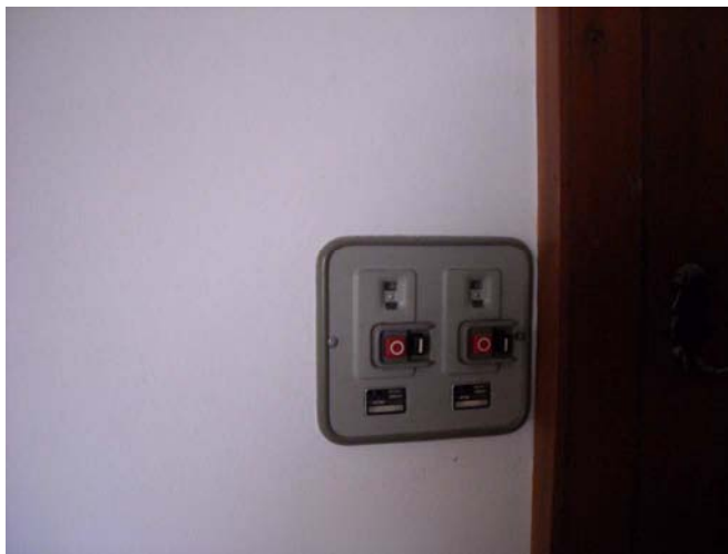
Foto 21 vista disimpegno dalla camera, foto 22 terrazzino, foto 23 quadretto elettrico
