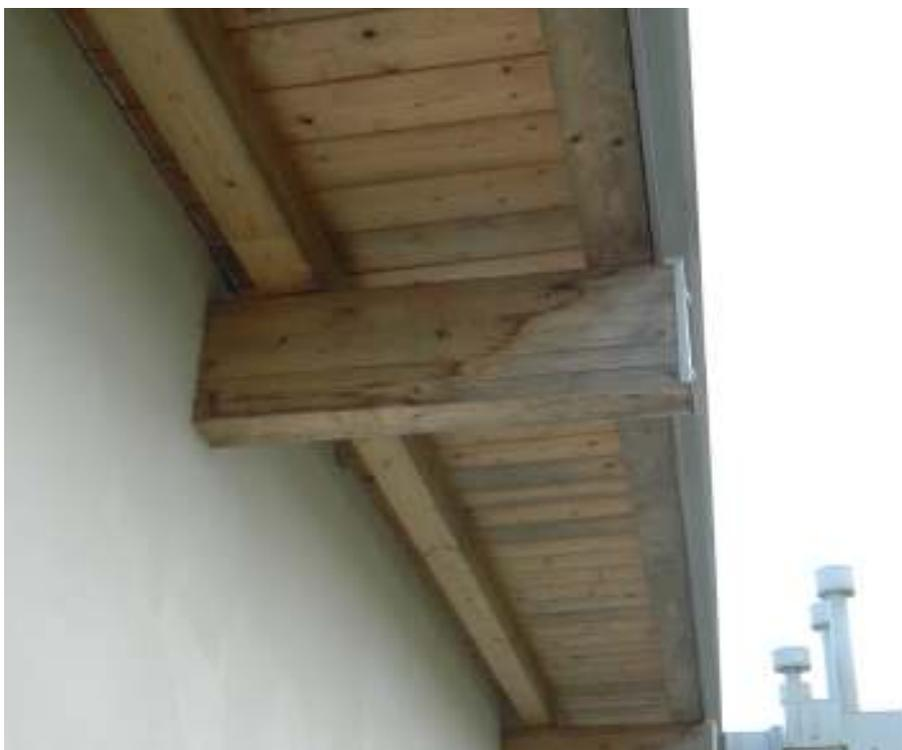
Foto n. 56 – Segni di degrado alle componenti lignee del tetto.
