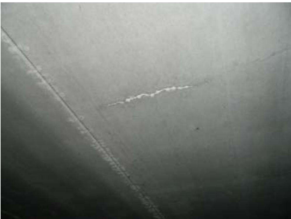
Foto n. 50 – Stato dei luoghi dell'interrato: infiltrazioni dal solaio.
