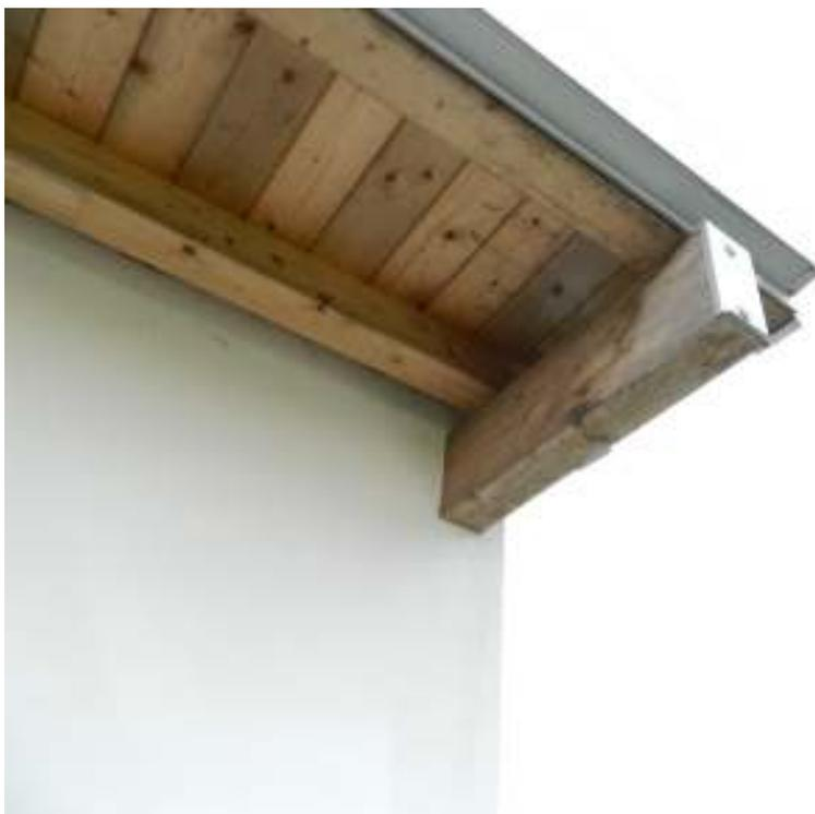
Foto n. 55 – Segni di degrado alle componenti lignee del tetto.
