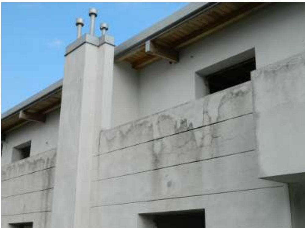
Foto n. 53 – Stato dei luoghi: distacco di intonaco dai terrazzini al piano primo lato nord.
