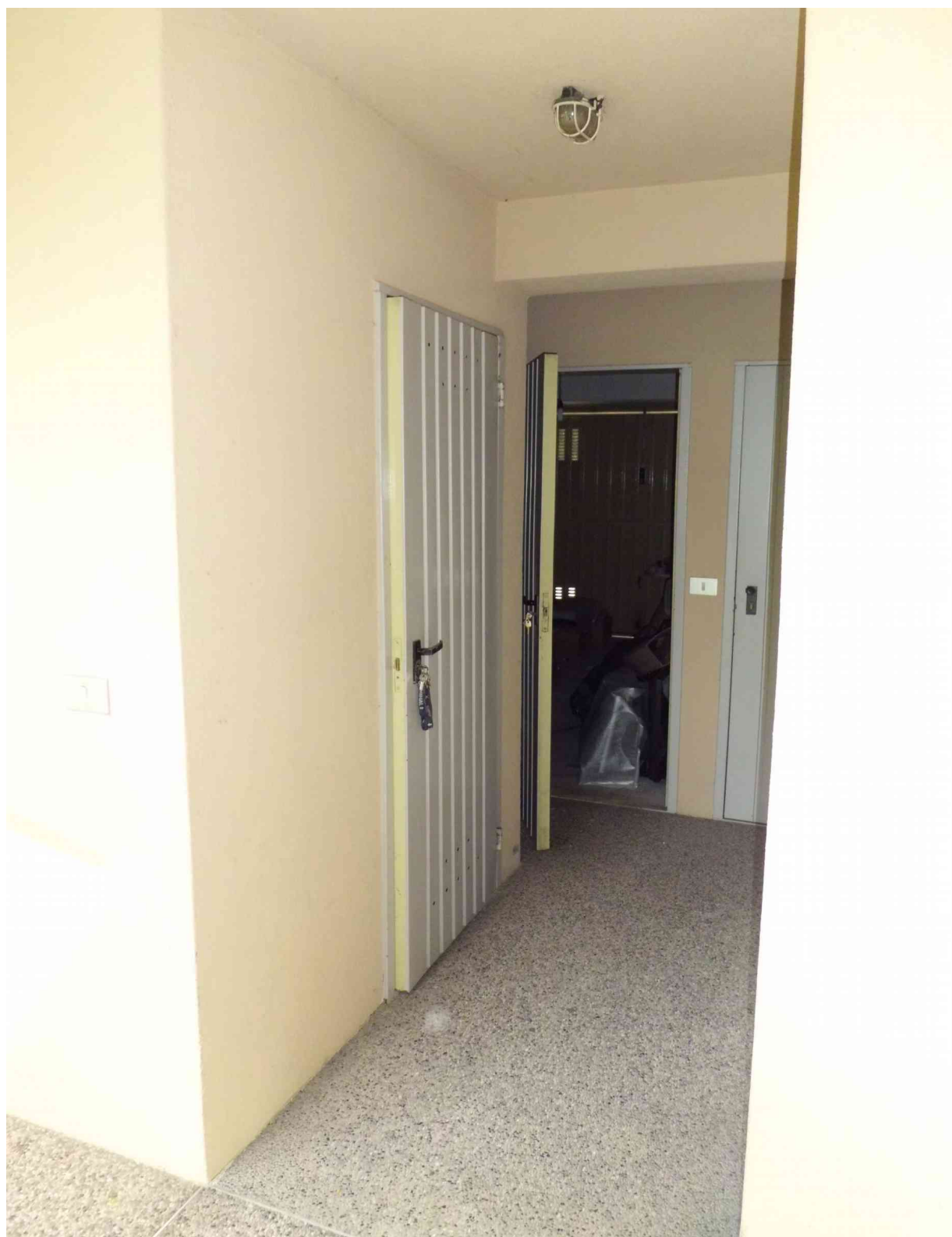
Foto n° 17 - 18/04/2016 - Comune di Pordenone, foglio 13, part. 581 - Breve corridoio che da accesso alla cantina (prima porta a sinistra) ed al garage sub.47 (porta frontale).
