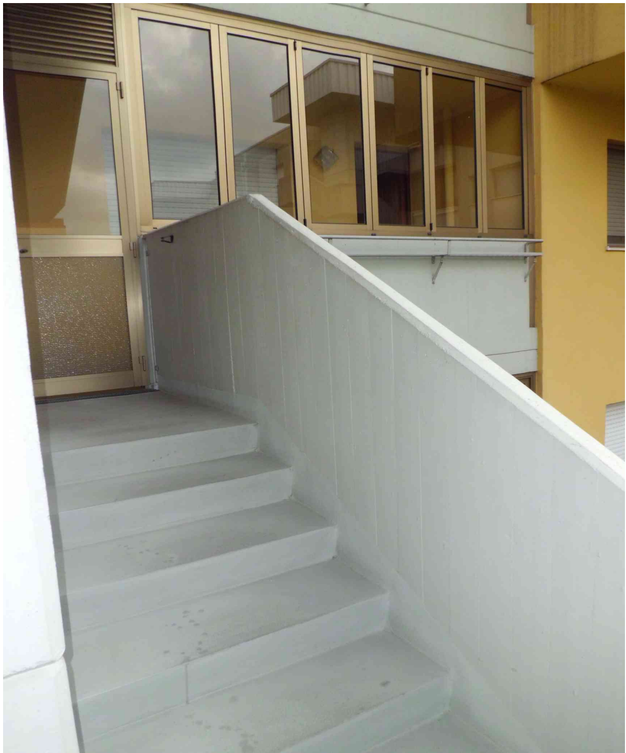
Foto n° 5 - 18/04/2016 - Comune di Pordenone, foglio 13, part. 581 - Vista esterna dell'appartamento pignorato. L'accesso avviene tramite la veranda esterna visibile in questa foto.
