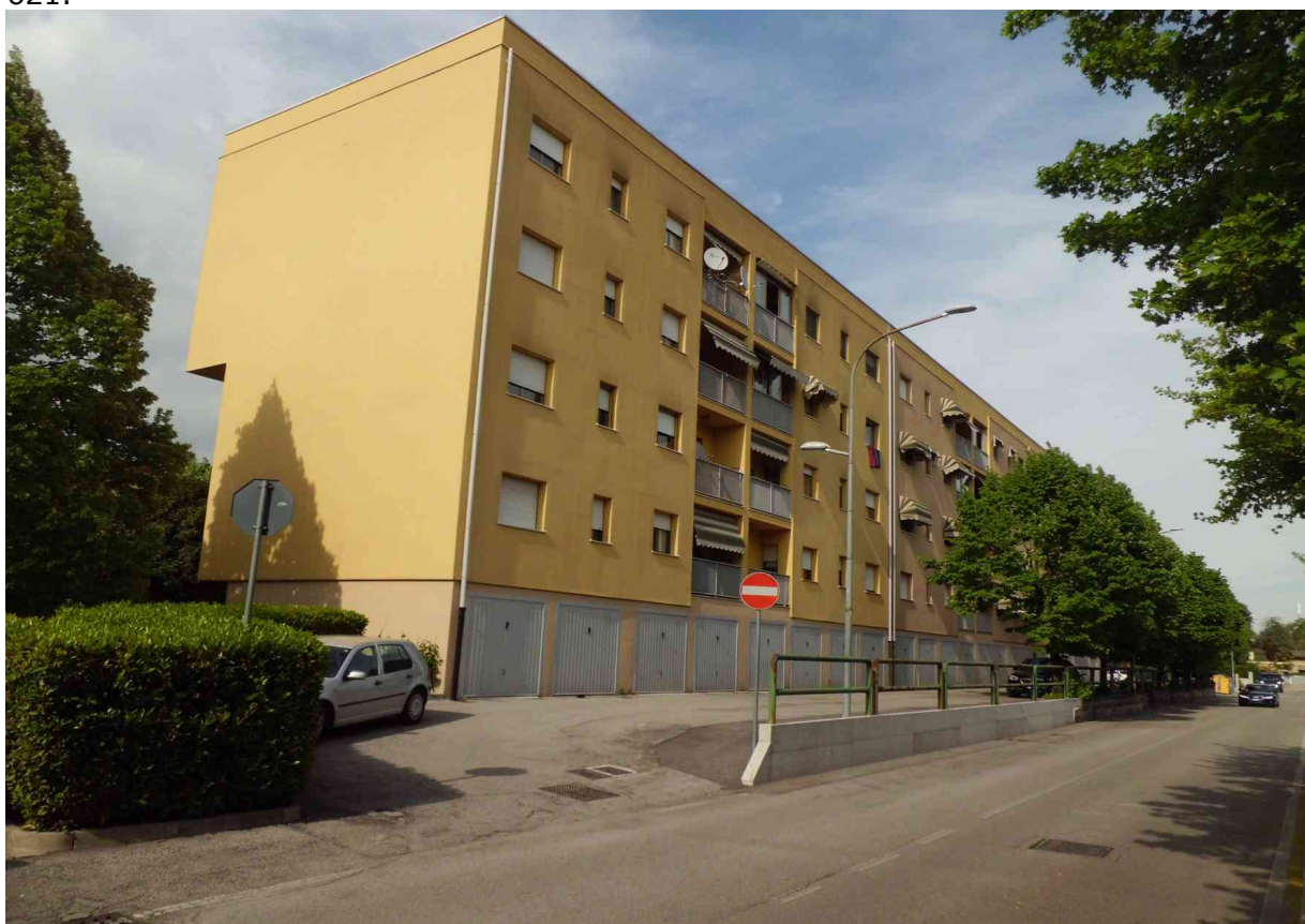
Foto n° 2 - 18/04/2016 - Comune di Pordenone, foglio 13, part. 581 - Veduta generale del condominio, lato sud. Foto scattata da Via Colvera.
