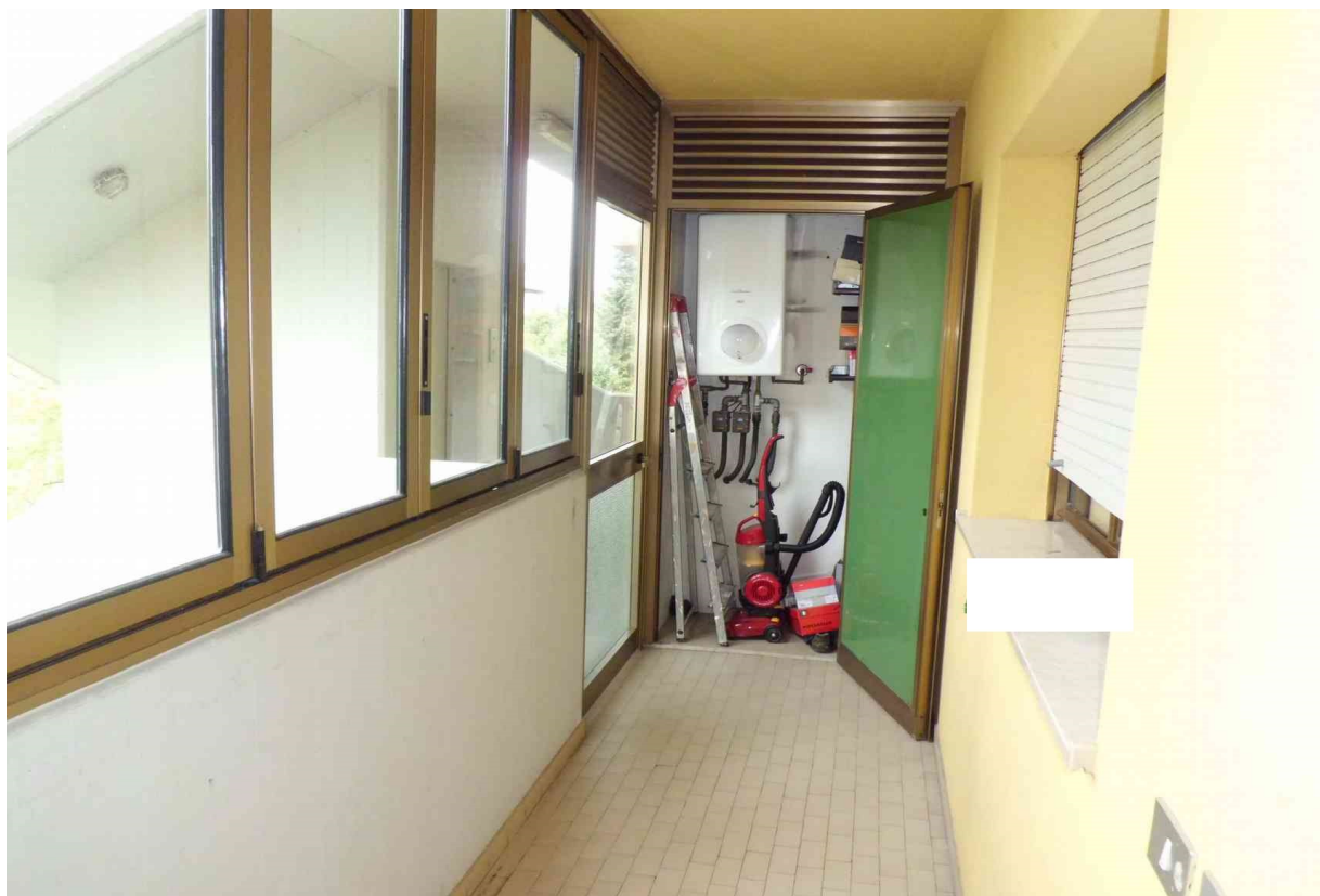
Foto n° 6 - 18/04/2016 - Comune di Pordenone, foglio 13, part. 581, sub. 69 - Veranda esterna. Sullo sfondo visibile la porta che divide la zona adibita a centrale termica. Fotografia scattata dal portoncino di ingresso dell'appartamento.
