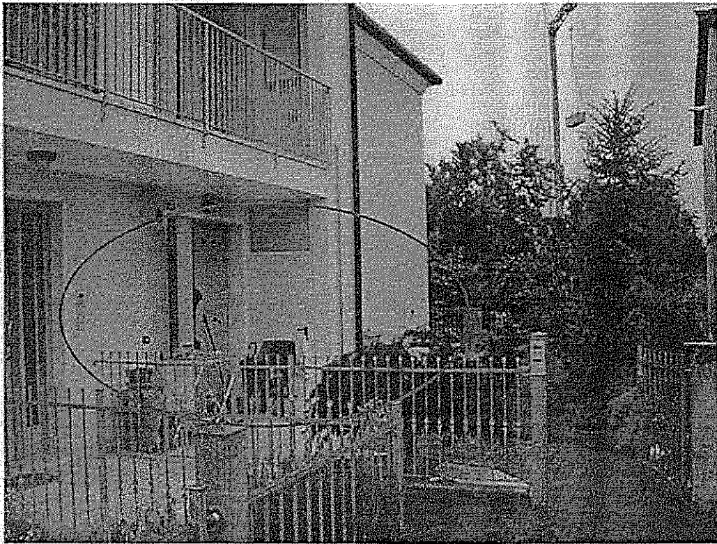
FOTO N° 6: Vista del cancelletto di accesso all'area scoperta di cui al M.N. 1771 sub 20, di porzione di essa e dell'accesso all'appartamento di cui al M.N. 1771 sub 4.
