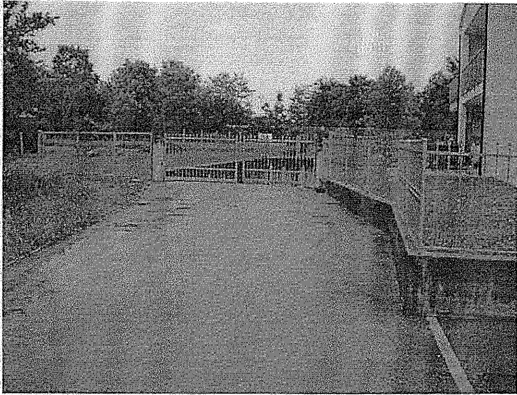
FOTO N° 5: Vista della rampa comune di accesso ai garage ubicata a nord del Condominio.
