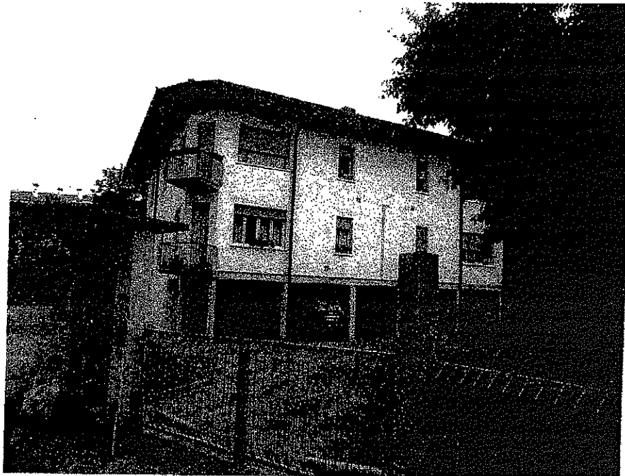
FOTO 1: vista prospetto esterno - strada ingresso del condomini
