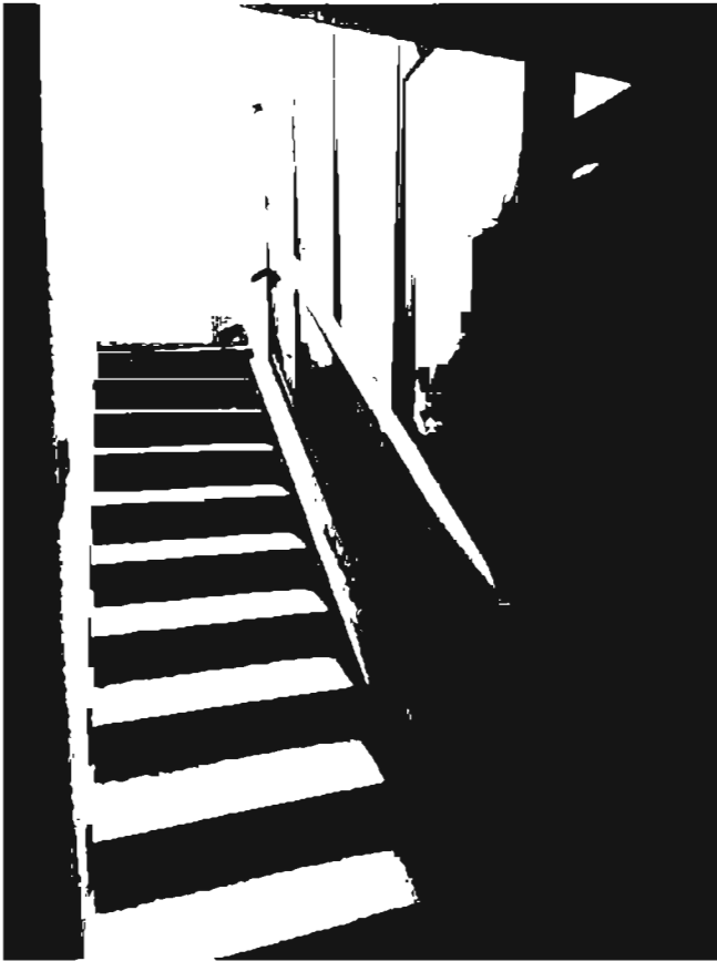
PALAZZINA UFFICI P.S. (foto n.21)
