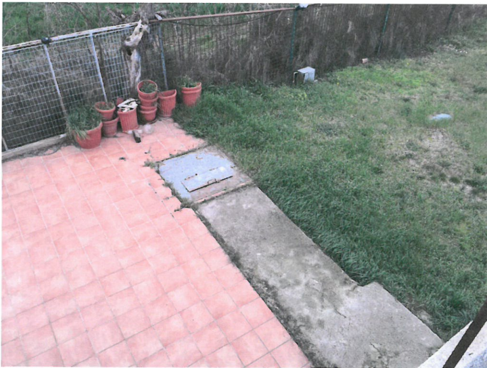
Foto n.08 - Particella n.29, vasca raccolta acqua piovana
