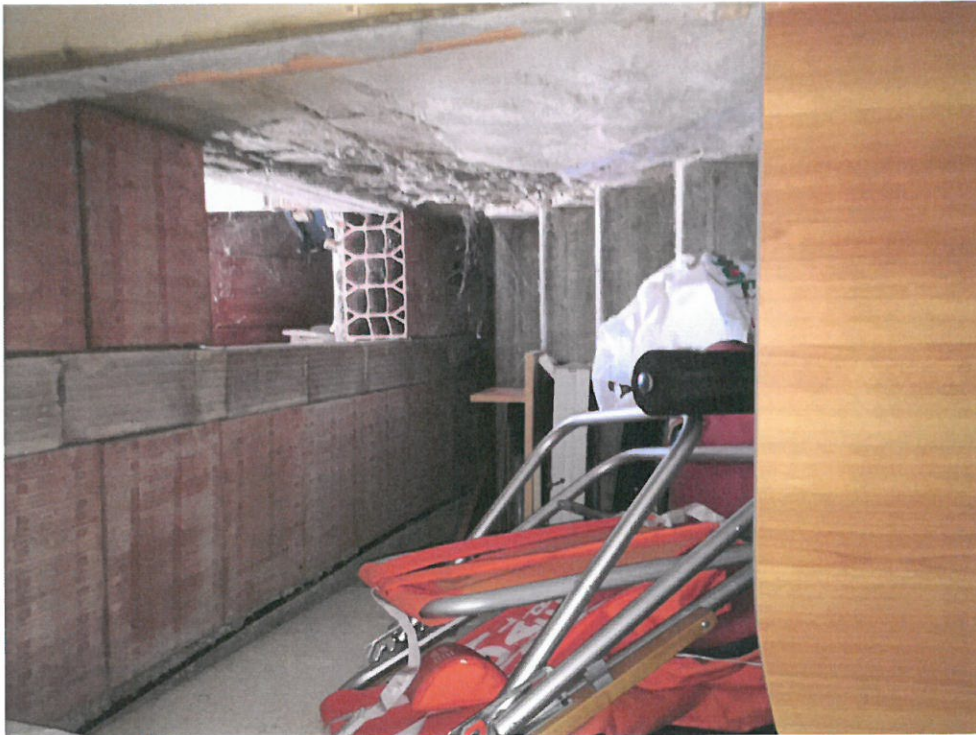
Foto n.26 - Ingresso dal w.c. piano primo per il piano soffitta.
