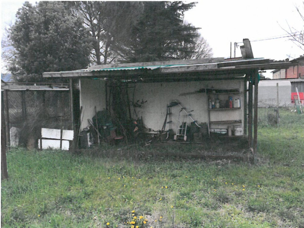
Foto n.04 - Particella n.29, baracche
