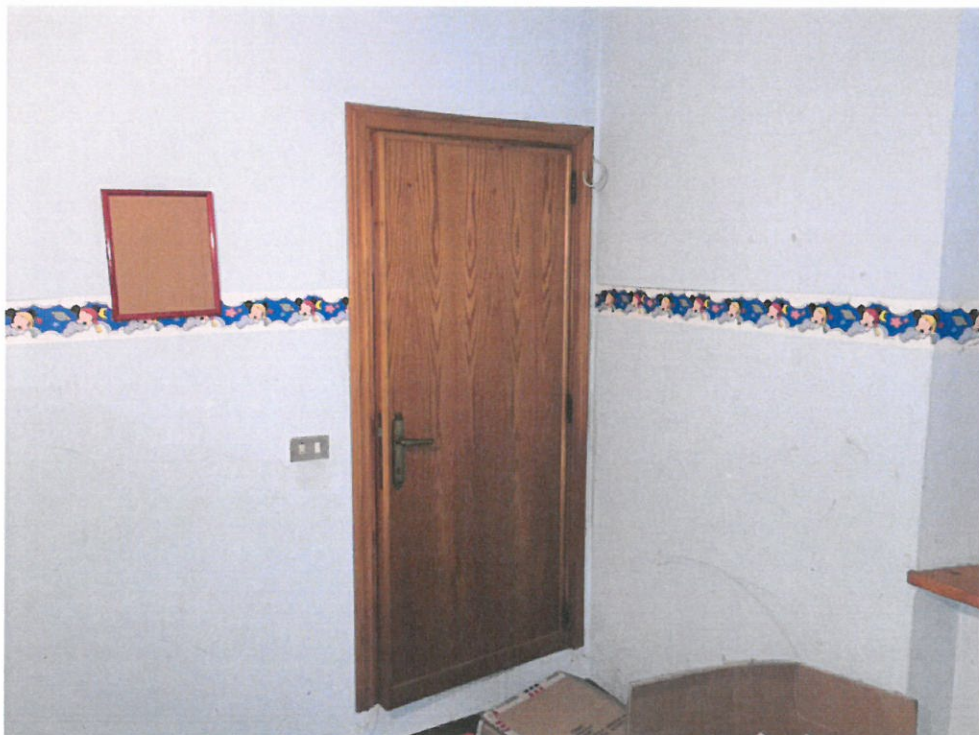
Foto n.24 - Ingresso del w.c. dalla camera da letto 1
