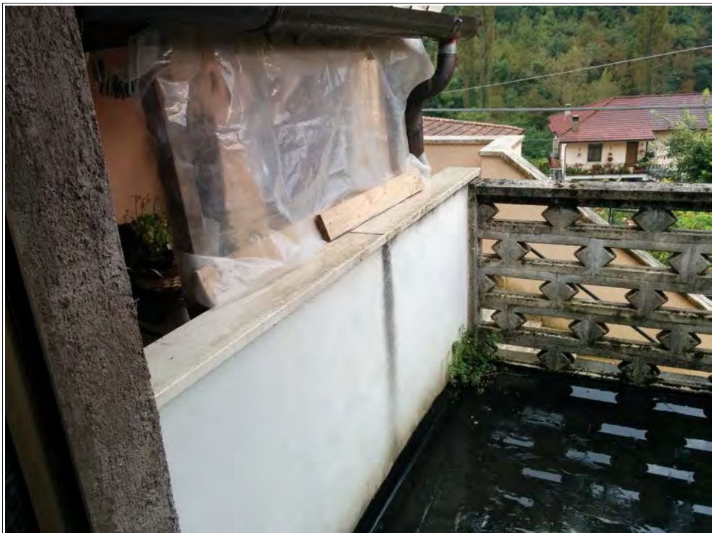
Foto 10 – Terrazza piano primo
