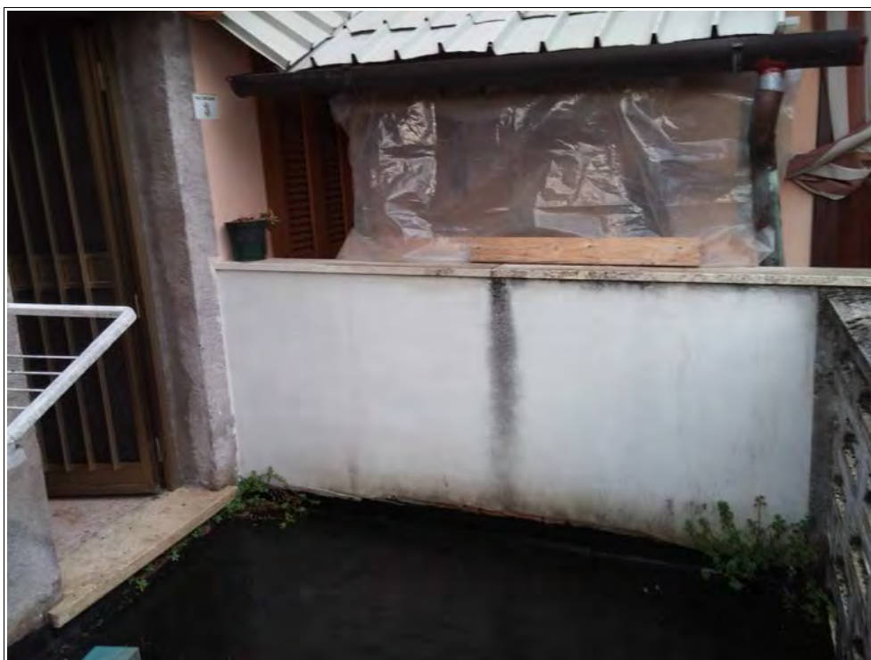
Foto 11 – Terrazza piano primo
