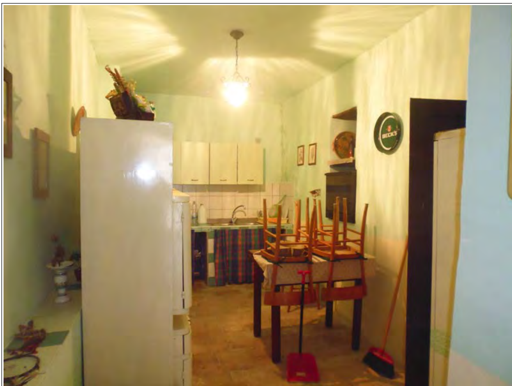
Foto 4 -Locale cucina piano terra
