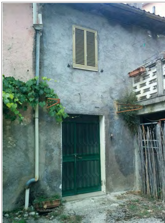
Foto 1 – Ingresso piano terra
