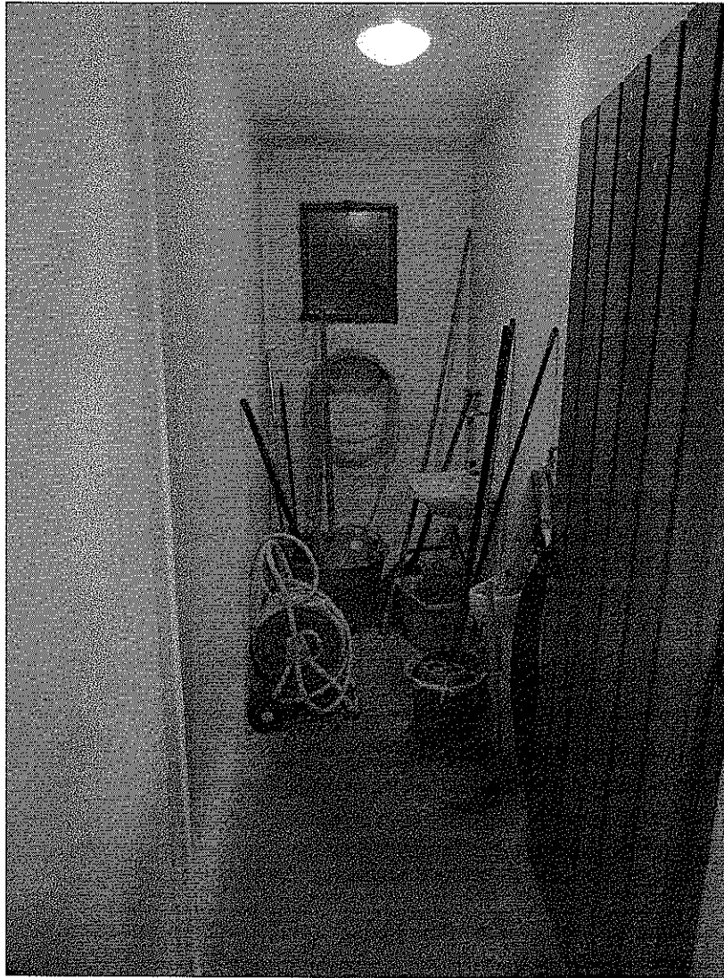
FOTO N°23 - vano w.c. comune al P.T. -
