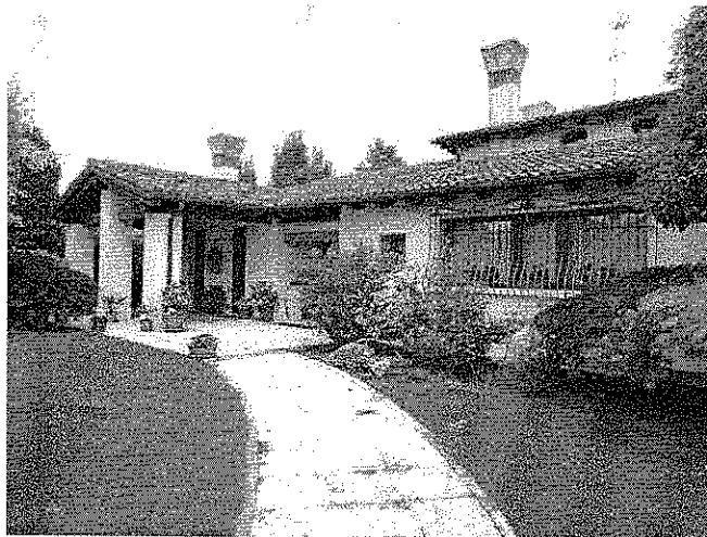
Immagine 6 ingresso all'abitazione prospetto ovest
