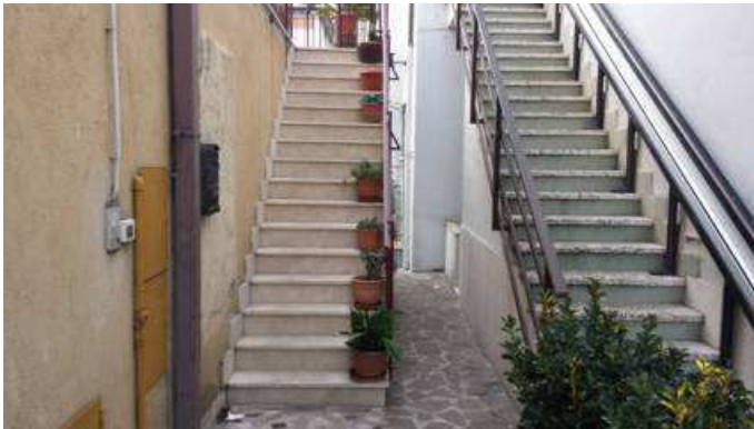
Scala di accesso all'appartamento
