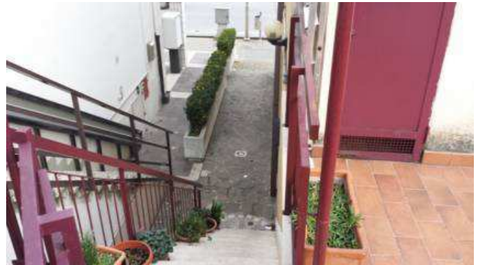
Scala di accesso all'appartamento
