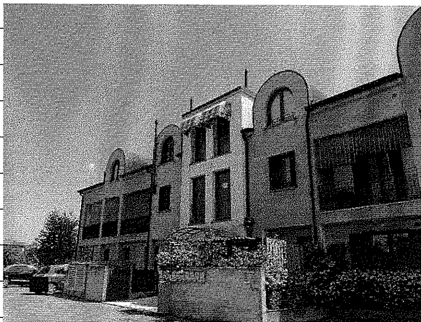
Foto Prospetto 1: Prospetto su Vicolo G. Marconi
