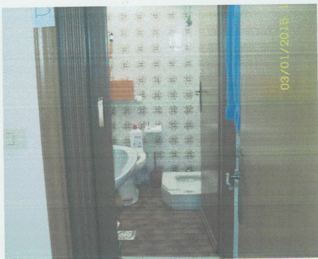
LOCALE SERVIZIO IGIENICO "B"
