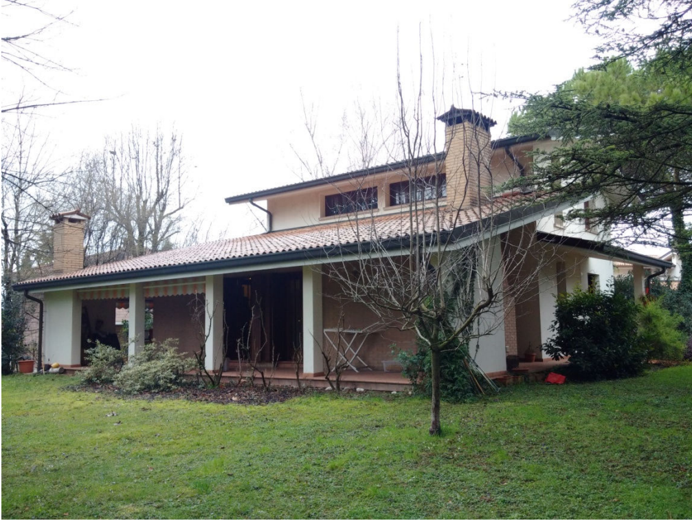
Foto n. 1 – Immobile esecutato dall'interno del giardino (lato Sud-Est).
