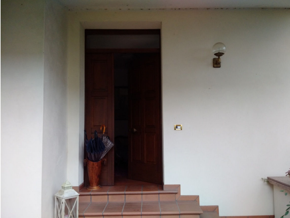
Foto n. 7 – Portoncino d'ingresso principale.
