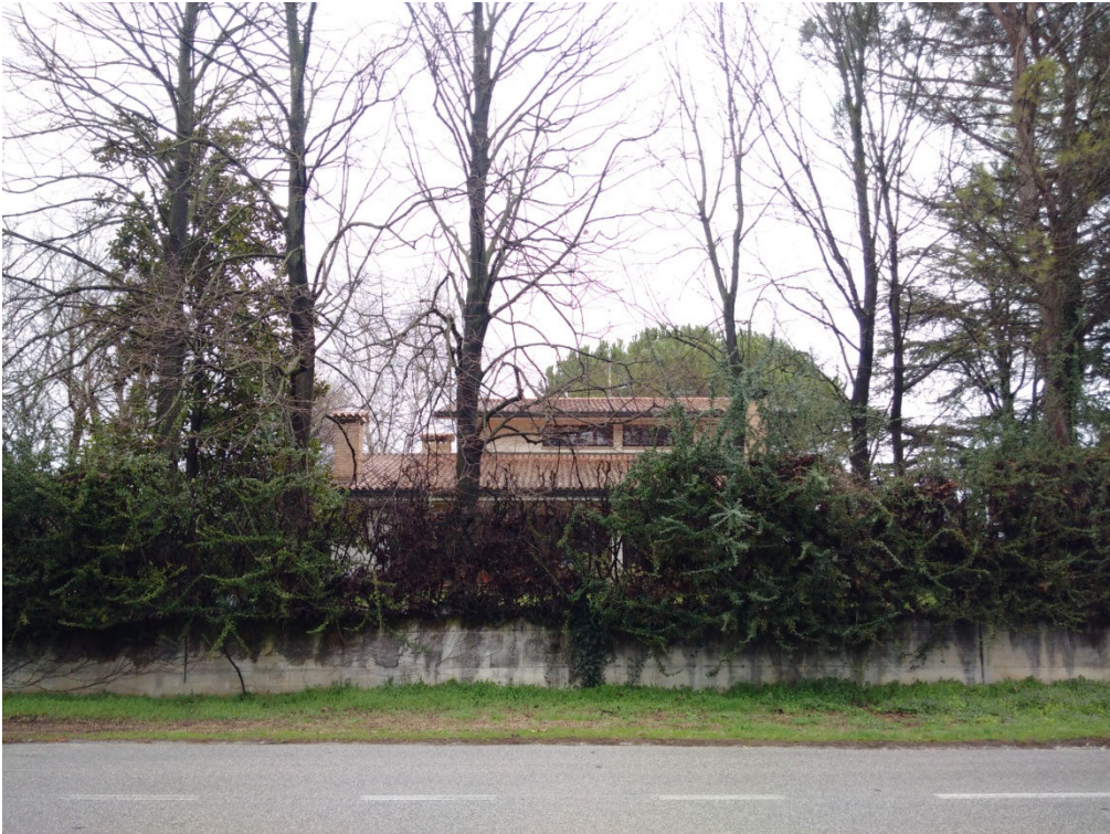
Foto n. 2 – Immobile esecutato visto da via Divisione Garibaldi (lato Sud).
