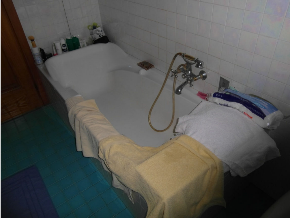
Foto n. 21 – Bagno principale piano terra. Dettaglio della vasca.
