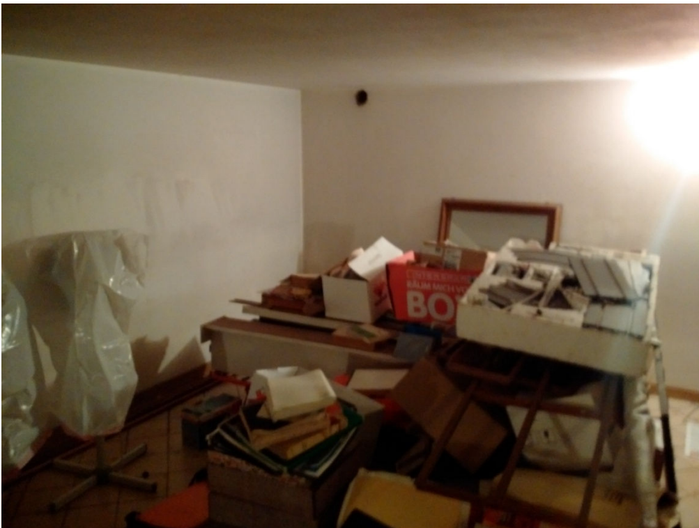
Foto n. 42 – Magazzino (privo di titoli autorizzativi) dell'interrato.
