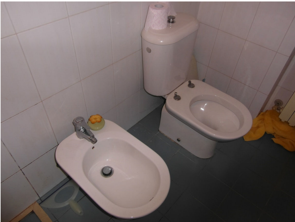
Foto n. 24 – Bagno secondario piano terra. Dettaglio sanitari.
