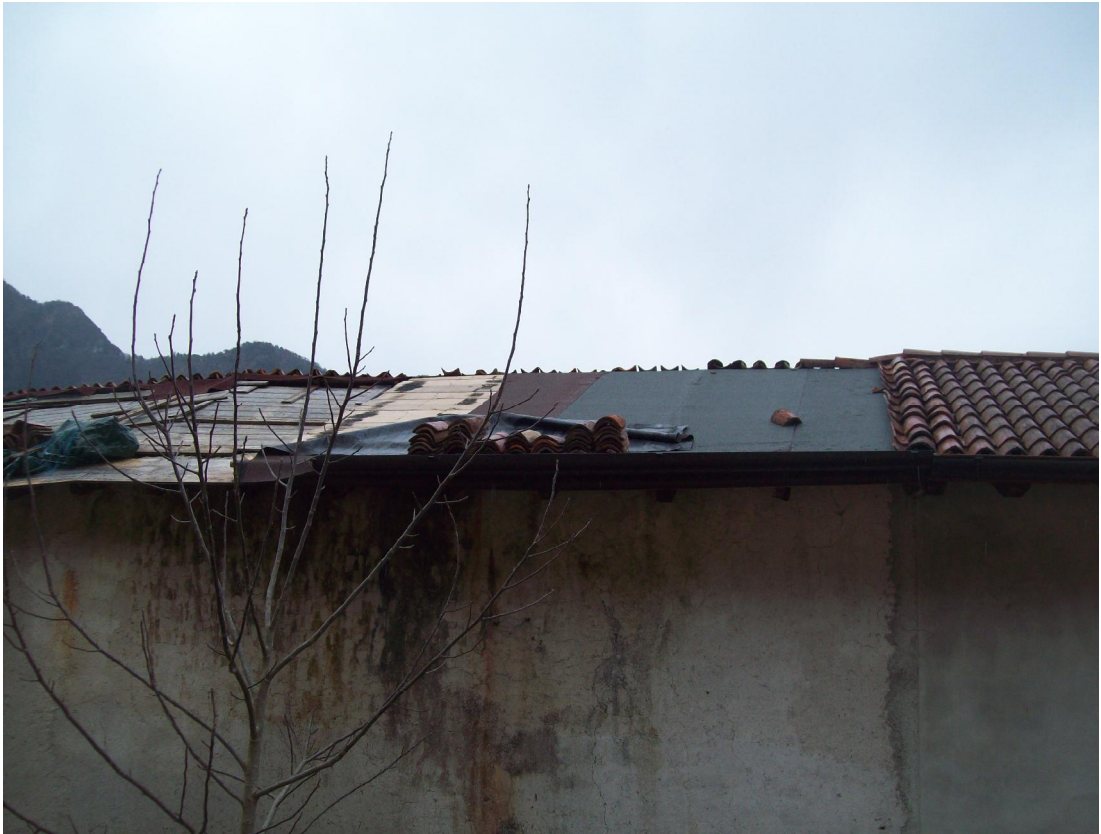
Foto 9: Falda tetto a Nord
