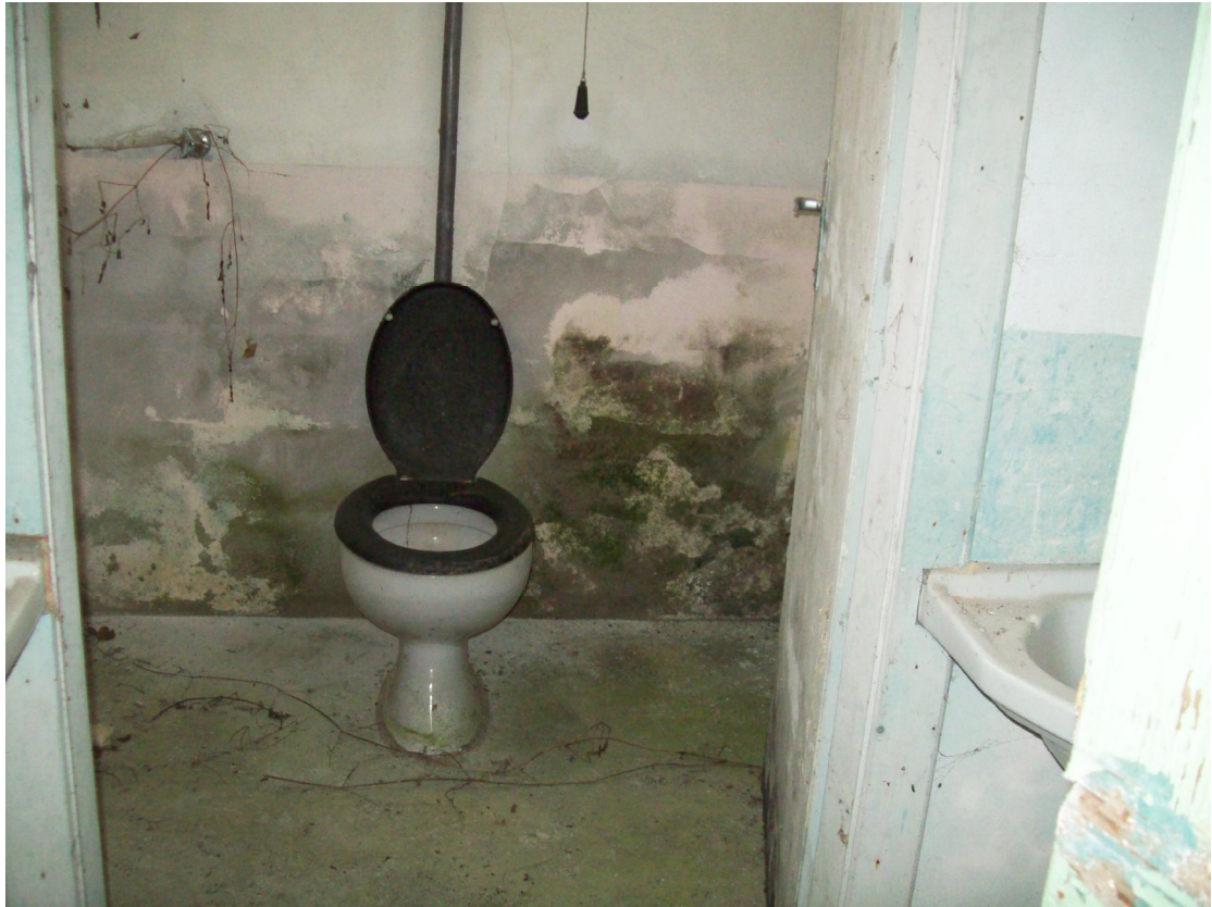
Foto 23: Bagno piano terra
