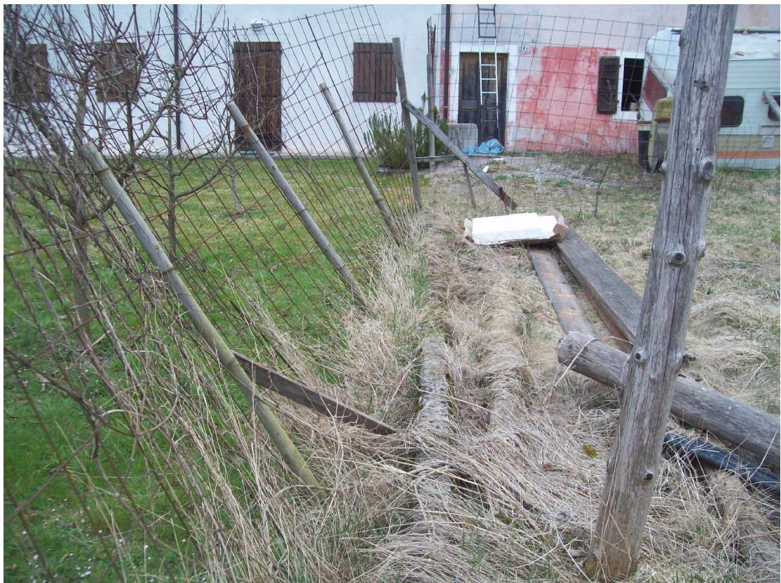
Foto 14: Recinzione di confine con il mappale 335
