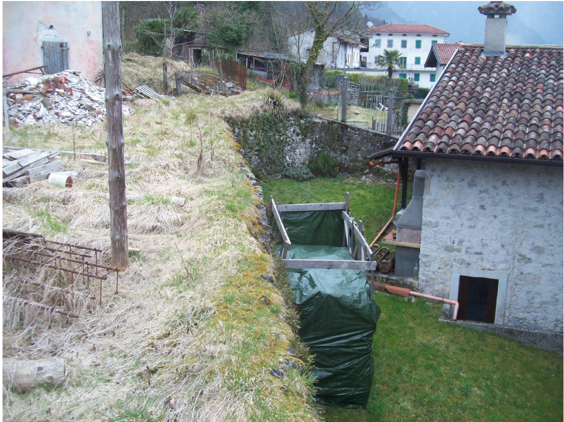
Foto 13: Muro di contenimento terreno confine a Sud
