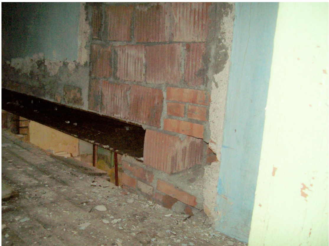
Foto 24: Muro tra camere a nord-est
