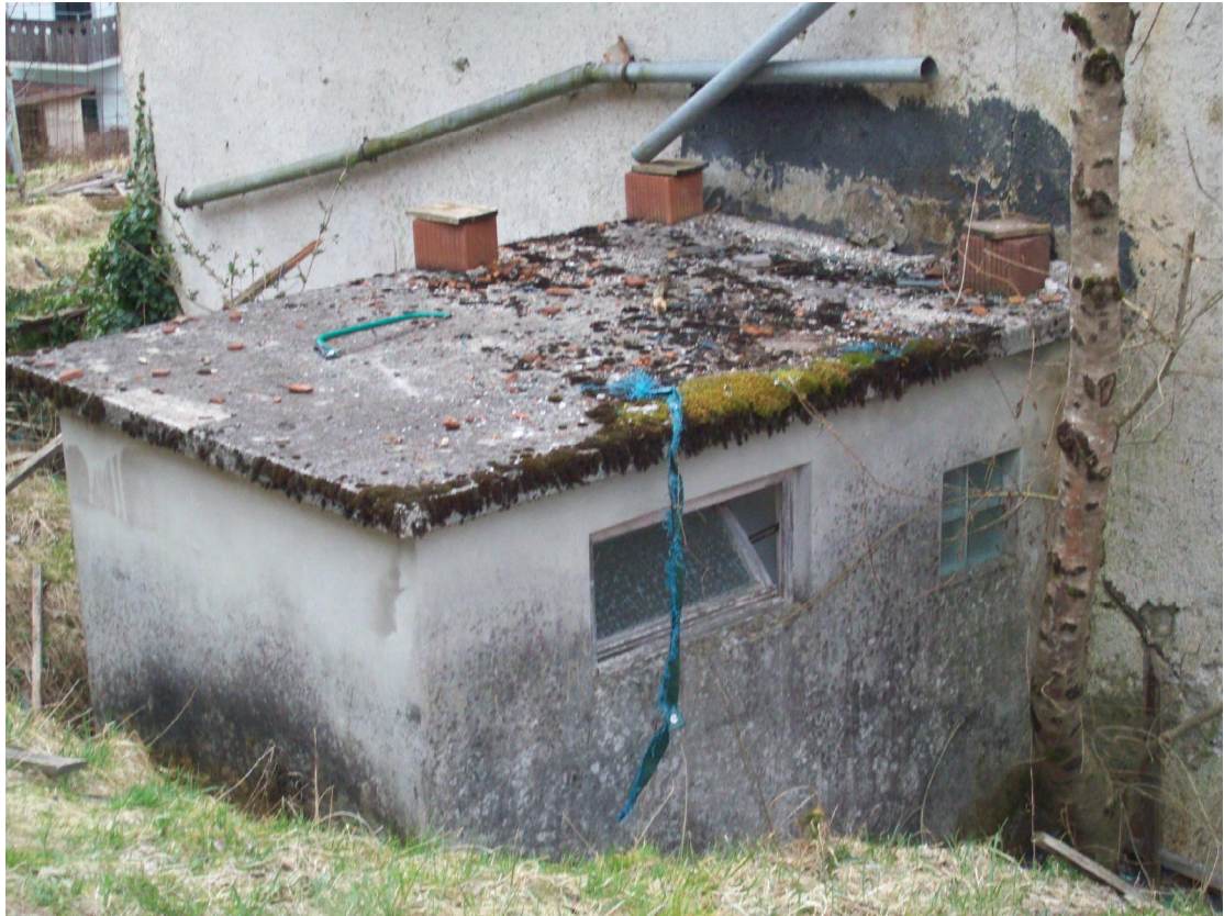
Foto 7: Corpo con copertura piana sul retro
