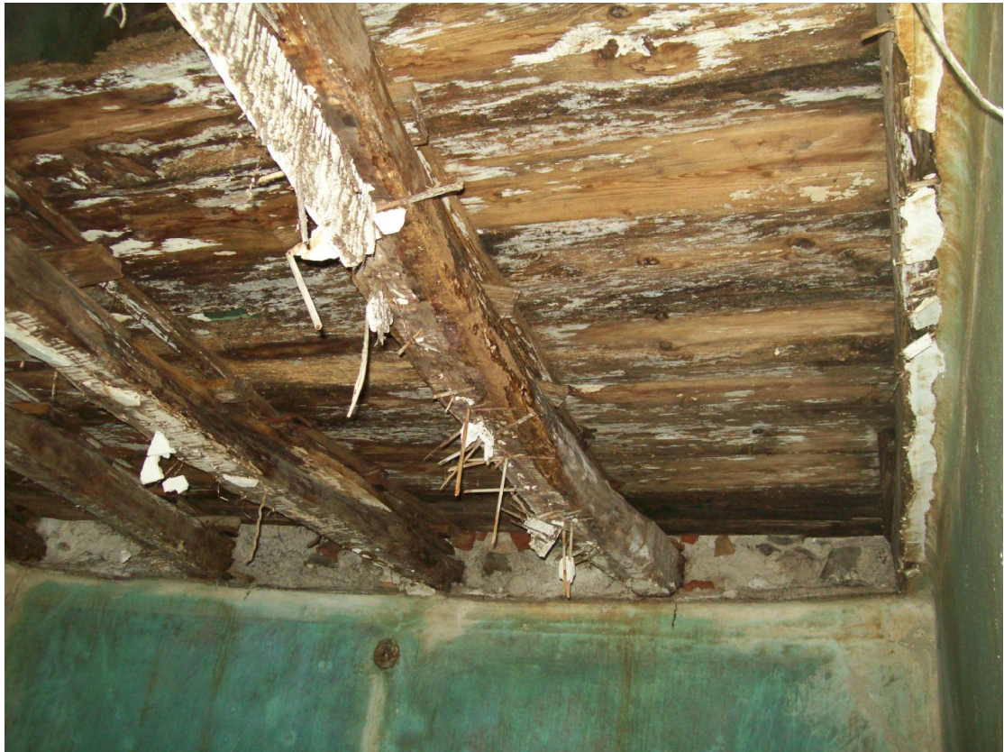
Foto 27: solaio secondo piano
