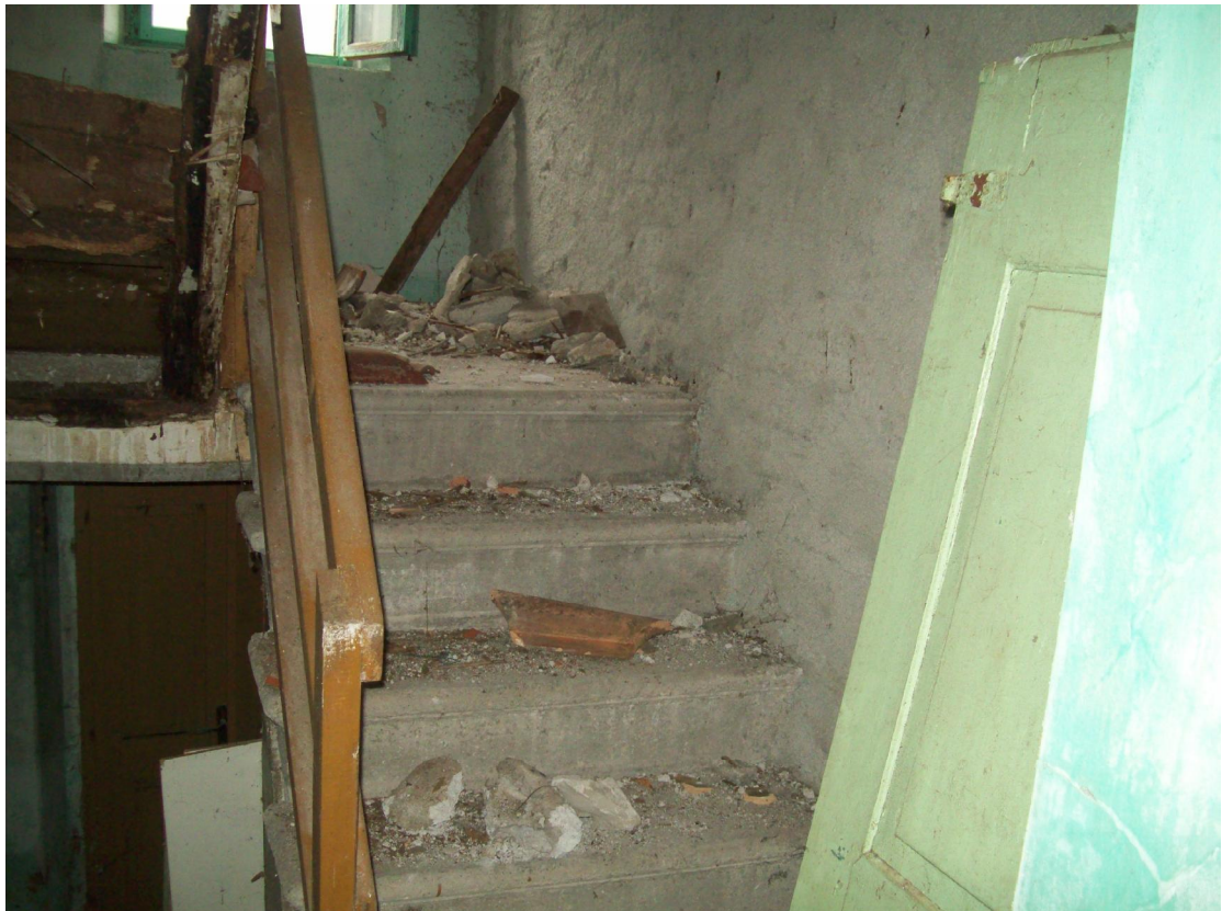
Foto 30: Rampa tra piano terra e secondo.
