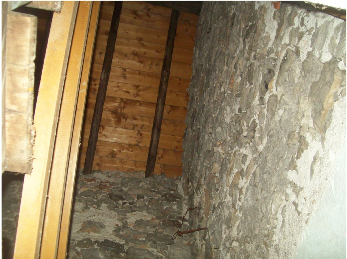
Foto 31: Tetto vano scale
