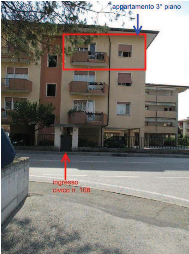
1) Facciata del fabbricato ed ingresso su via Roma
