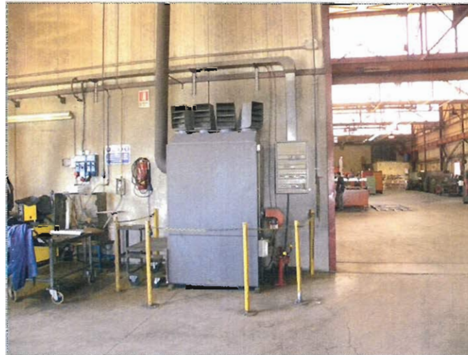
10) Immobili: interno blocco uffici/servizi 12) Impianti: generatore aria calda saldatura
