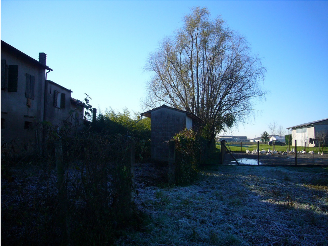
ESTERNO LATO NORD
