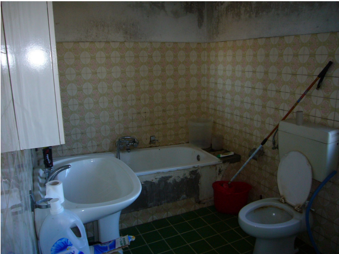
BAGNO PIANO PRIMO
