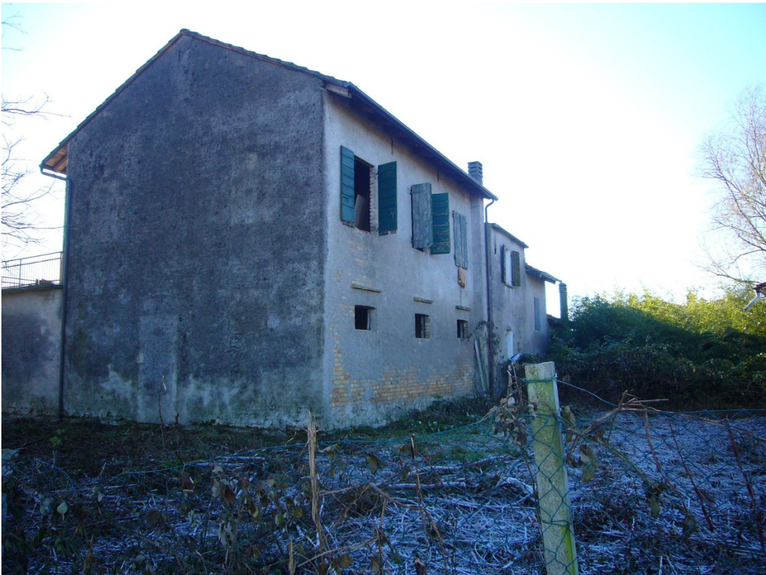
ESTERNO LATO NORD
