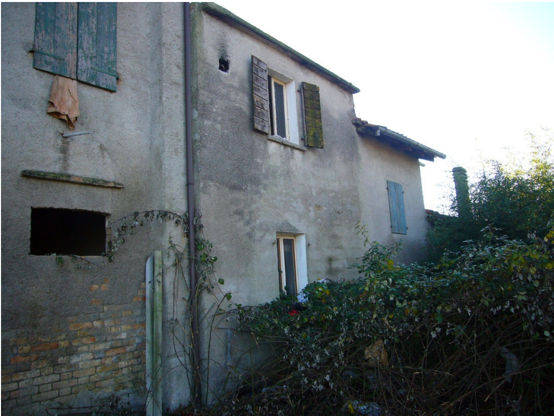
ESTERNO LATO NORD
