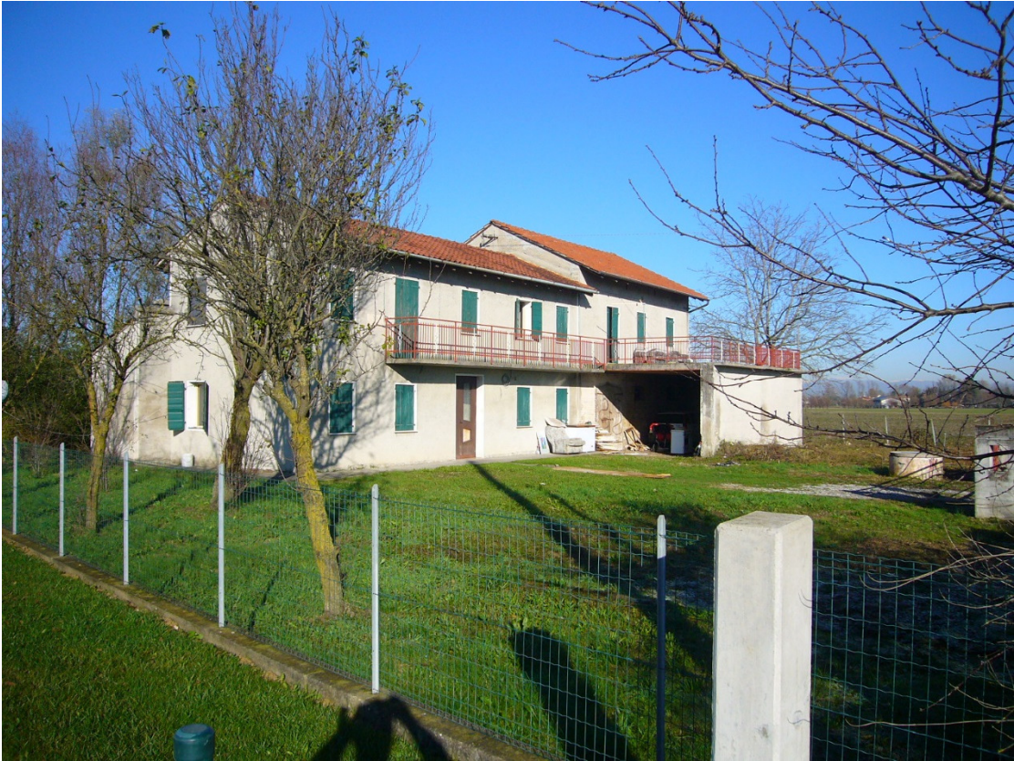
ESTERNO LATO SUD EST
