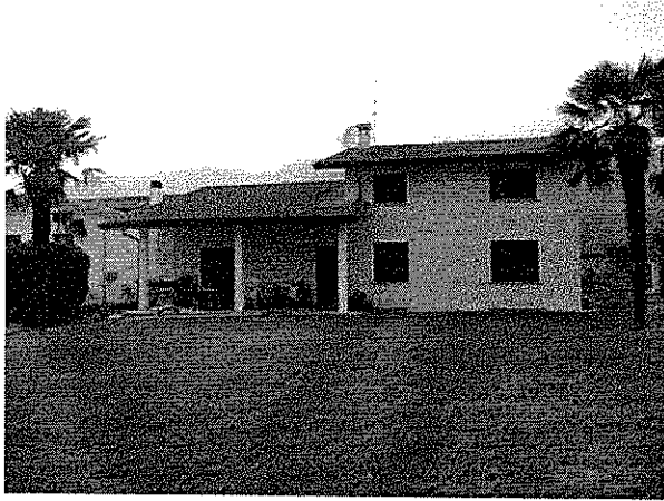
facciata ingresso - veduta da sud-est
