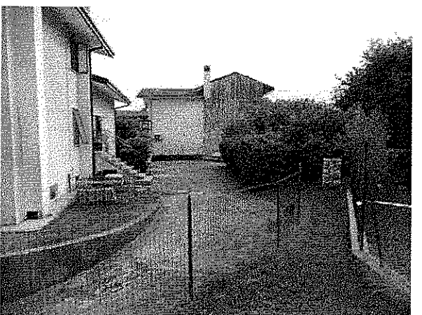
rampa ingresso autorimessa
