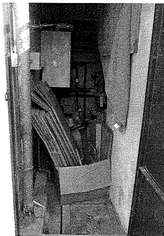
locale c.t. sottoscala
