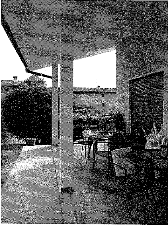
veduta portico – lato sud
