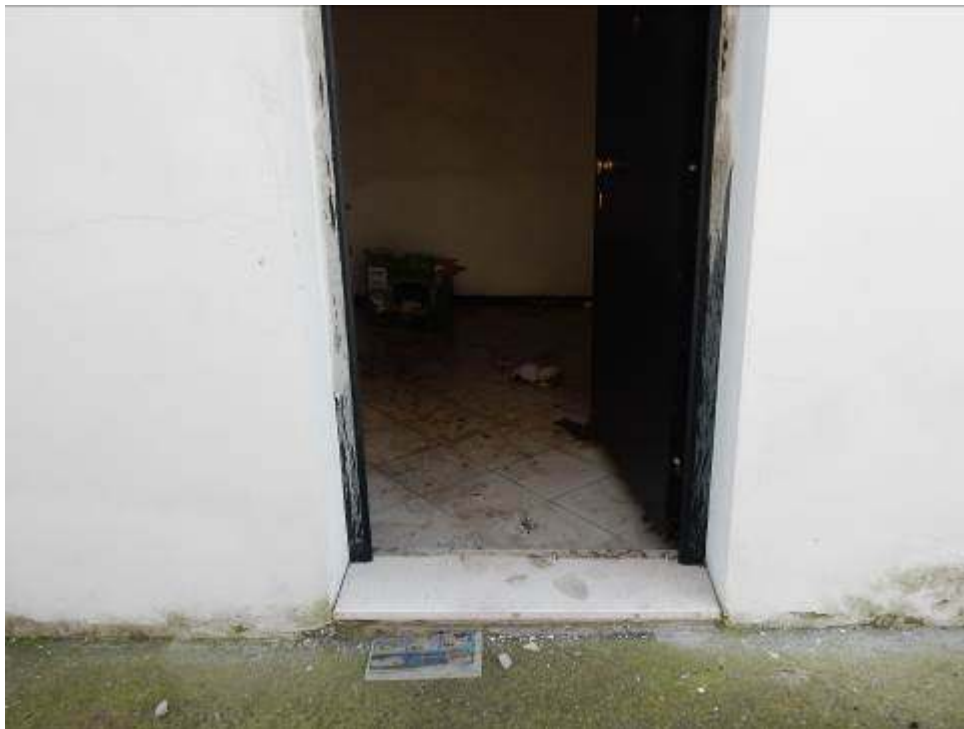
Foto 33-34: Ingresso negozio piano terra.
