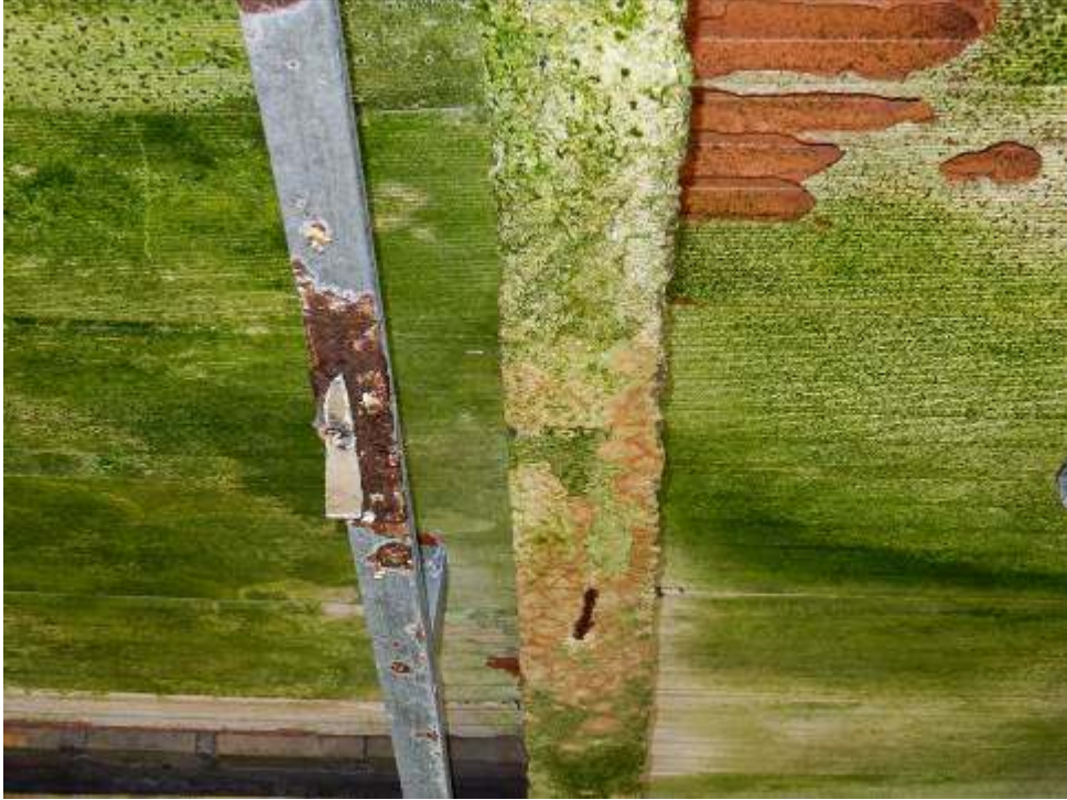
Foto 15-16: Interno garage piano terra.
