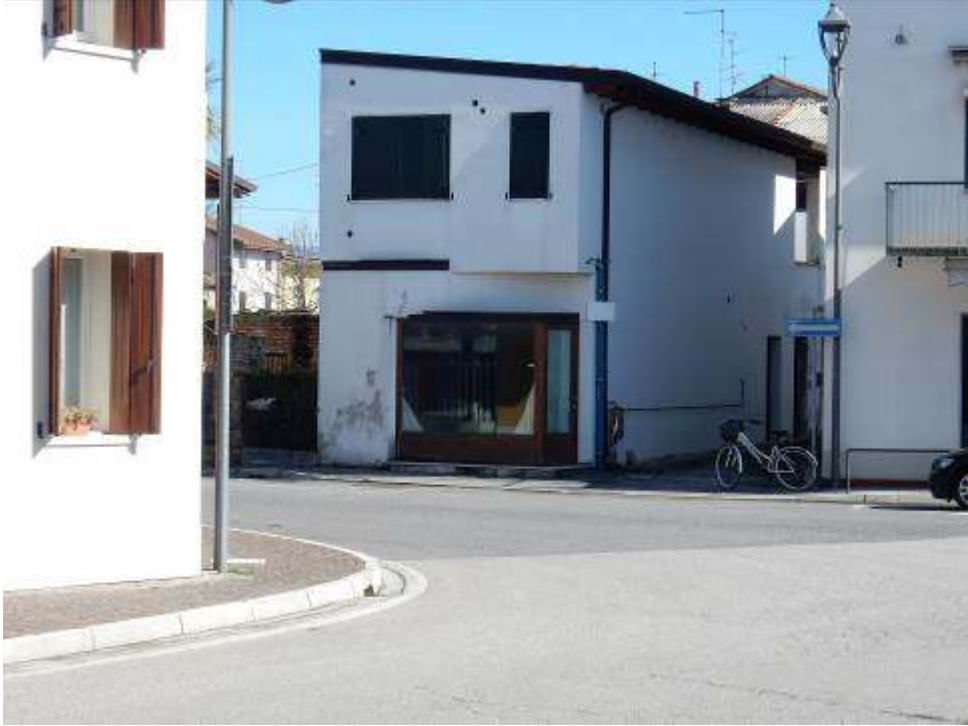
Foto 3-4: Fabbricato condominiale lati Sud-Ovest; Sud-Est.
