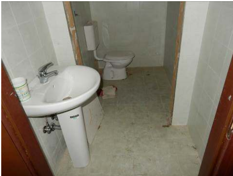
Foto 41-42: Bagno e quadro elettrico negozio.
