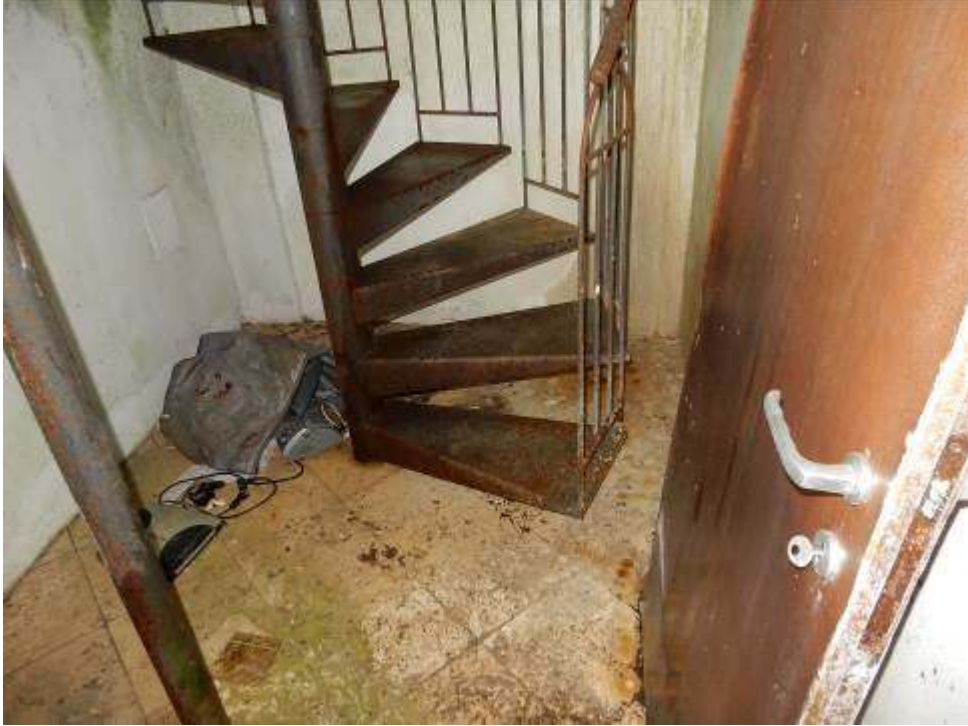
Foto 5-6: Ingresso appartamento piano terra e vano scale.
