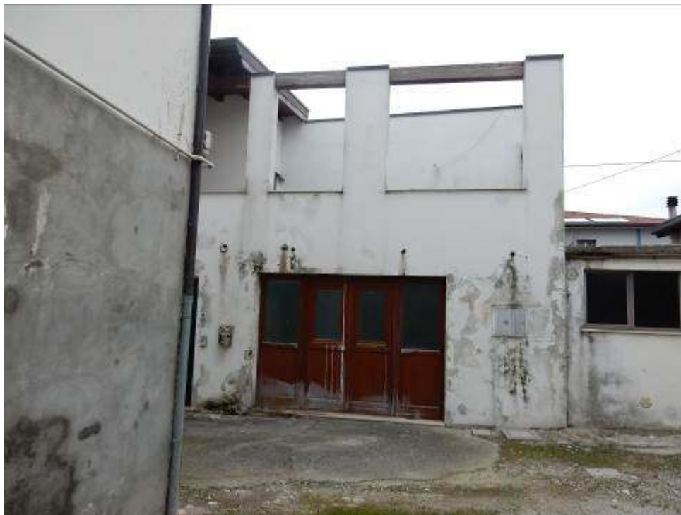
Foto 45-46: Pareti esterna lato Sud-Est.
