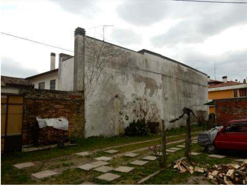
Foto 47-48: Parete esterna lato Nord.
