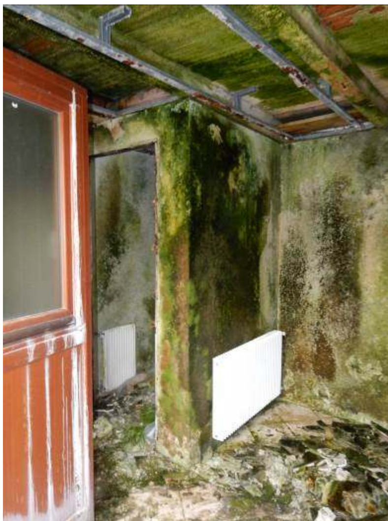
Foto 19-20: Interno garage piano terra.
