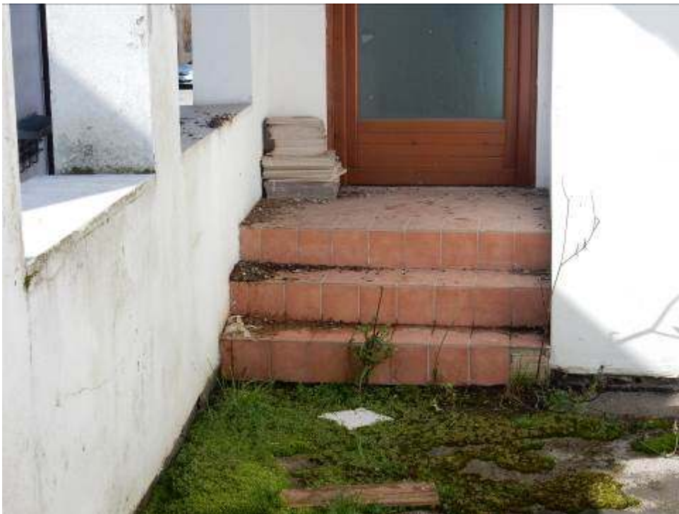
Foto 23-24: Ingresso monocale piano primo.
