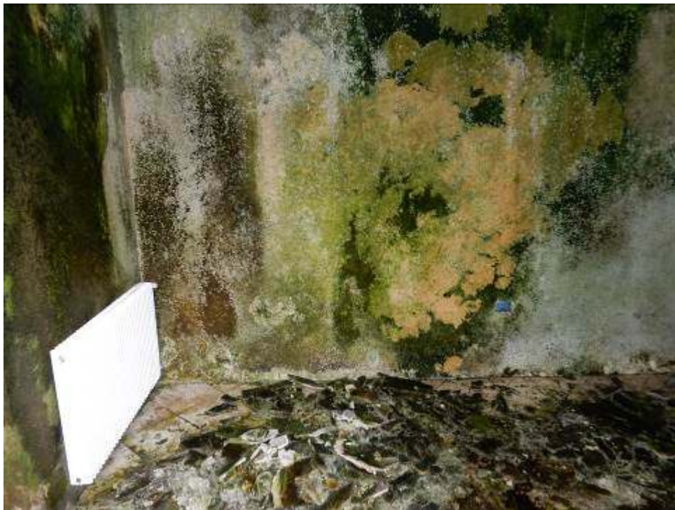
Foto 21-22: Interno garage piano terra e piano primo.
