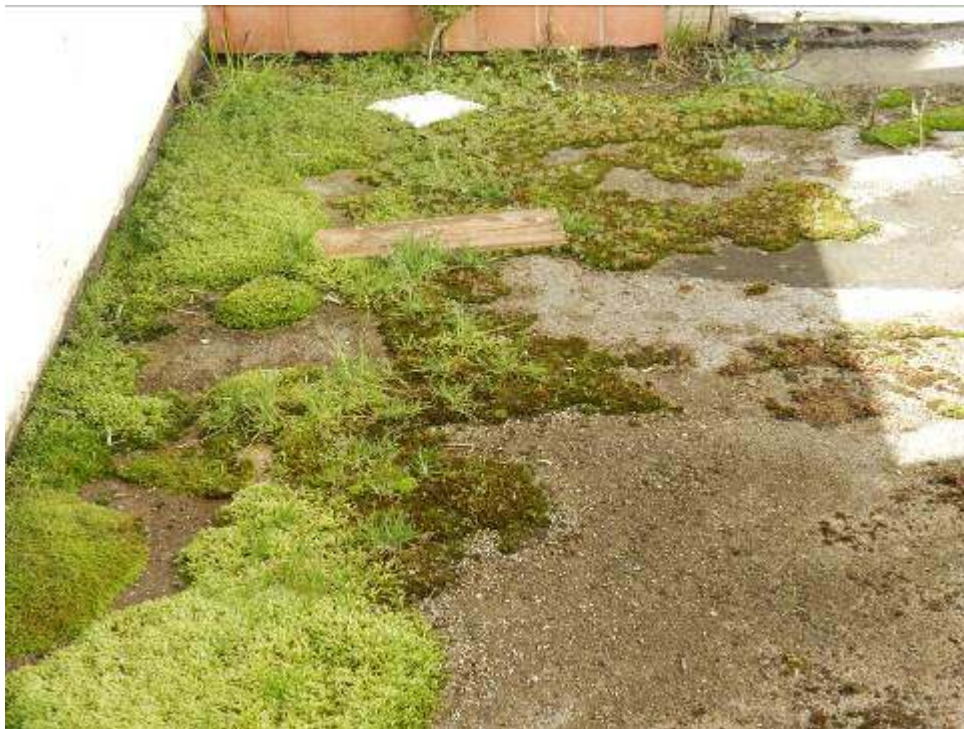
Foto 31-32: Terrazza piano primo.
