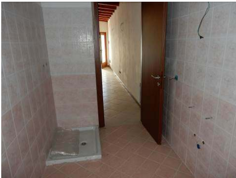
Foto 27-28: Bagno piano primo.
