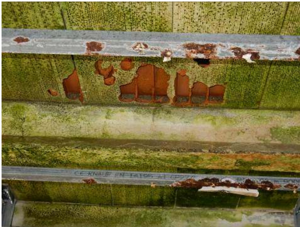
Foto 17-18: Copertura garage piano terra.
