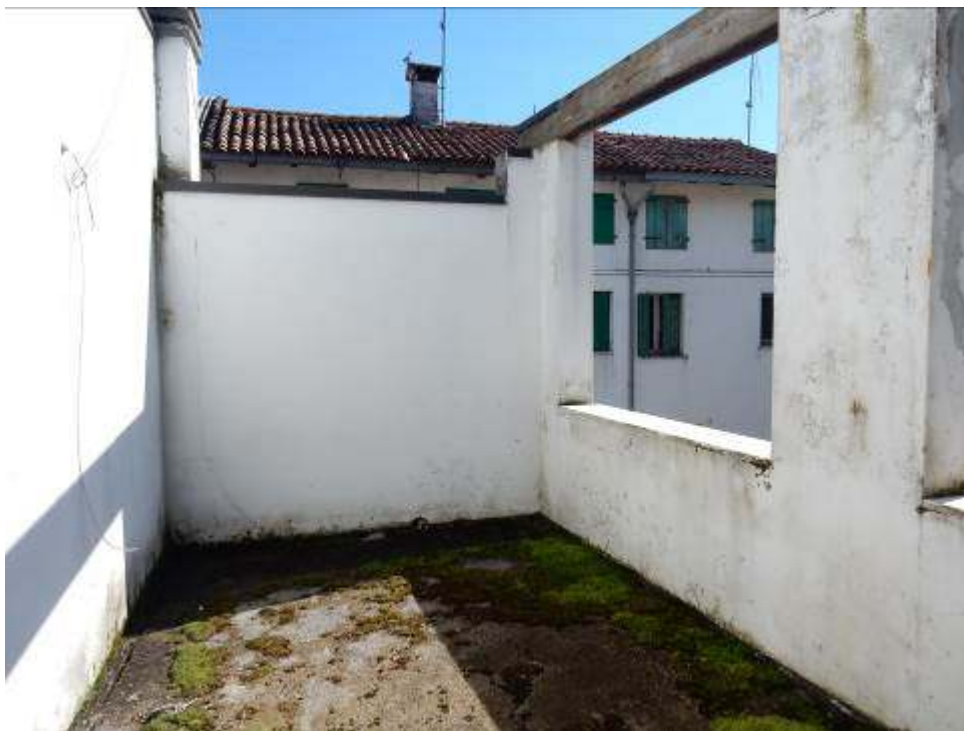
Foto 29-30: Terrazza piano primo.
