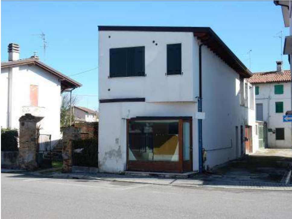
Foto 1-2: Fabbricato condominiale lati Ovest - Nord.
