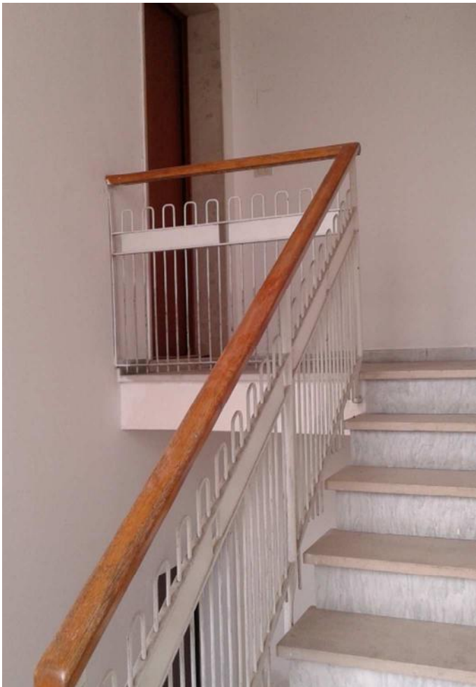
vano scala condominiale
