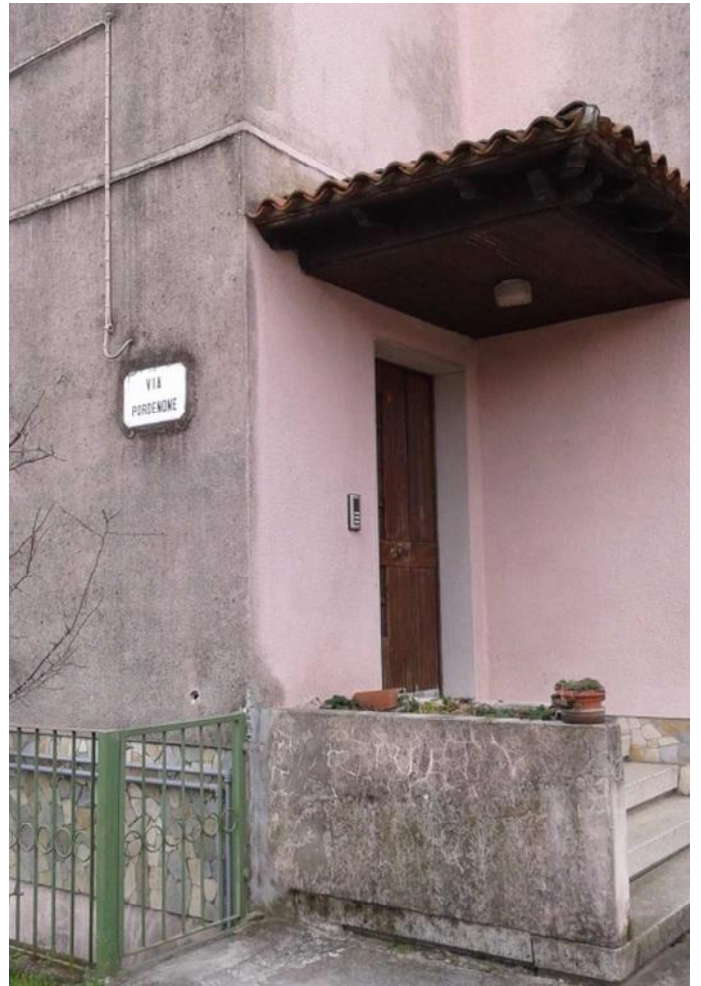
accesso vano scale condominiale
