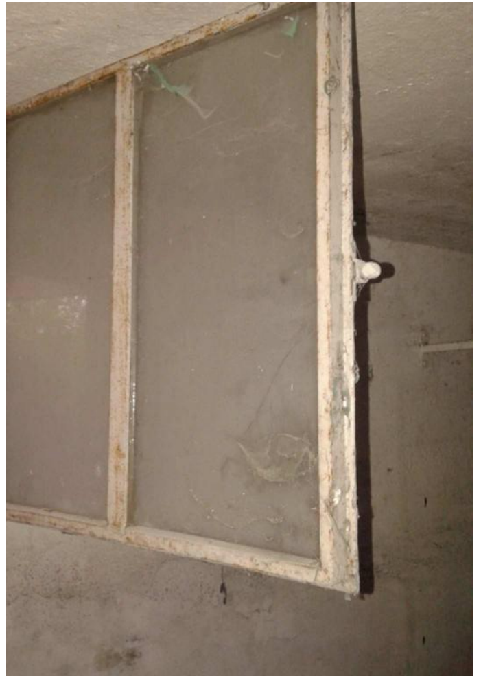
particolare serramento autorimessa
