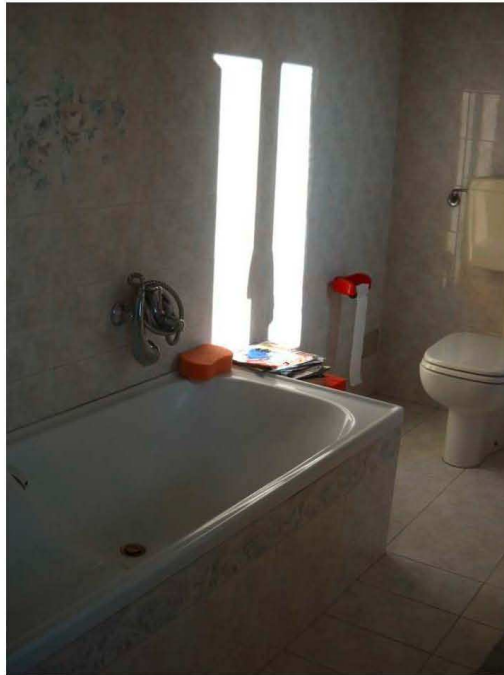
Foto 14 Bagno piano primo
