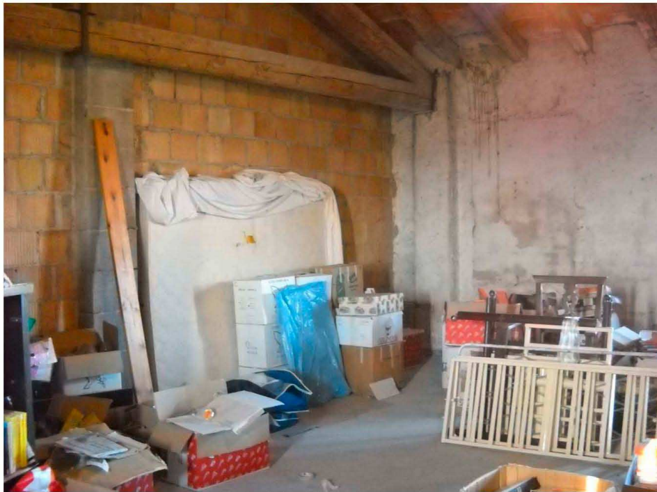
Foto 19 soffitta abitabile al grezzo
