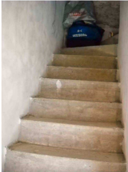
Foto 18 Scala interna al grezzo da primo a secondo piano
