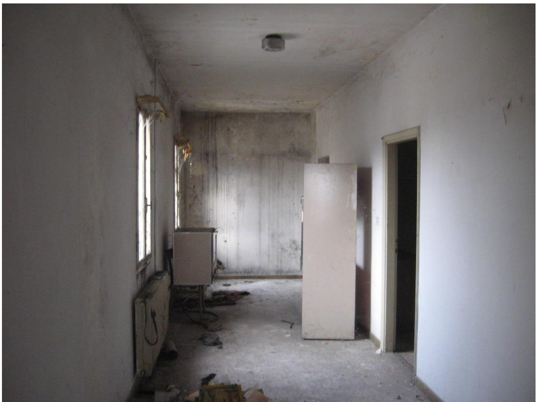
Il corridoio dell'unità abitativa
