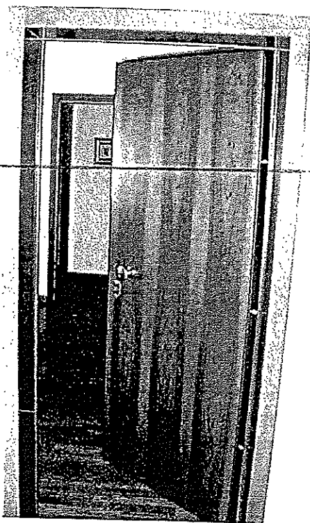
FOTO N° 8: Vista della porta di ingresso all'appartamento di cui al M.N. 1098 sub 32.
