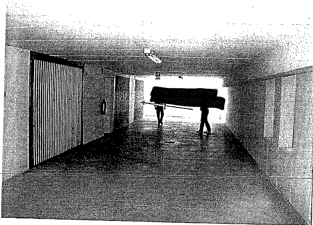
FOTO N° 7: Vista della corsia di manovra comune. L'autorimessa di cui al M.N. 1098 sub 54 è l'ultima a est.
