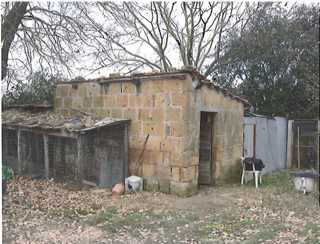
Illustrazione 5: fabbricato in muratura e manufatti in lamiera da demolire
