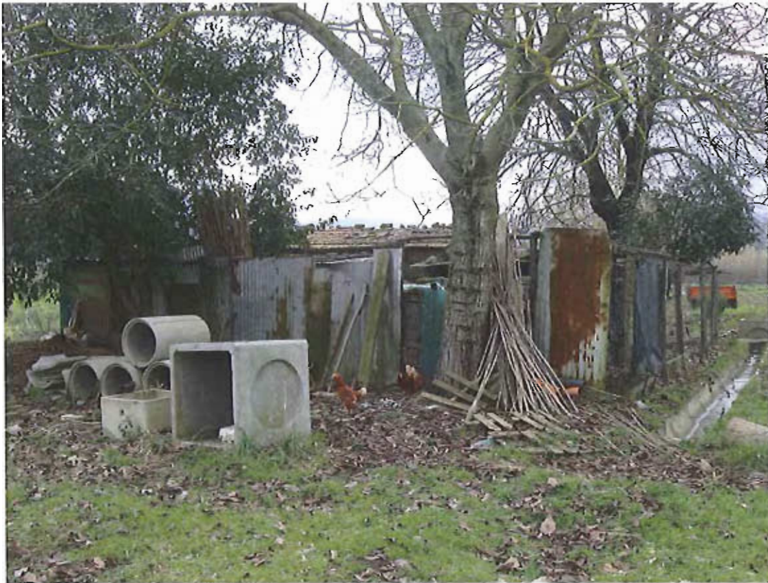
Illustrazione 6: manufatti in lamiera da demolire
