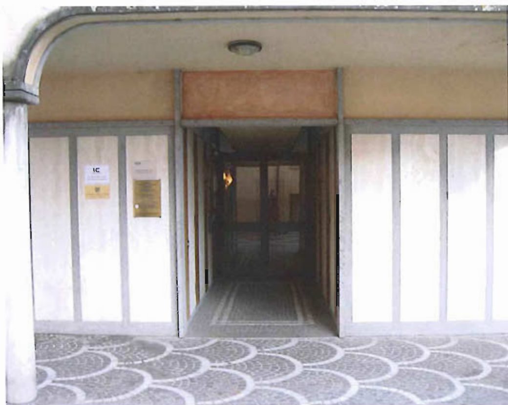
Illustrazione 14: foto esterna ingresso condominiale
