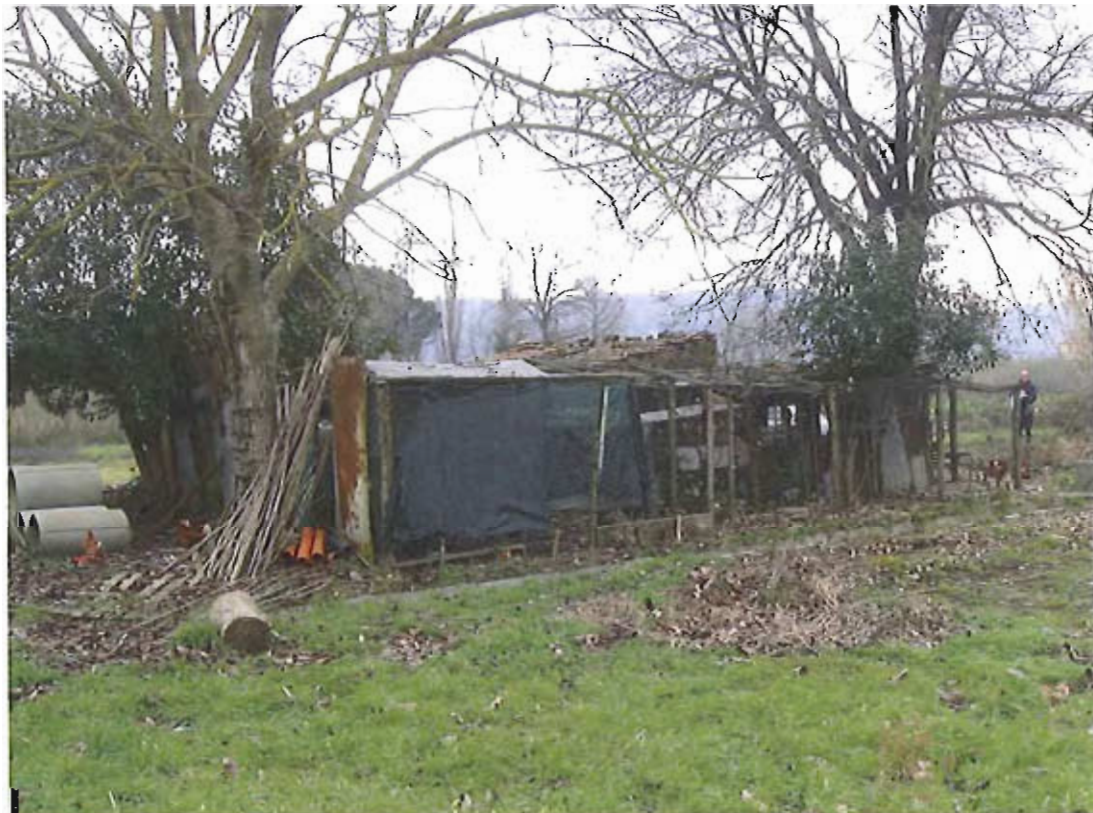
Illustrazione 7: manufatti in lamiera da demolire
