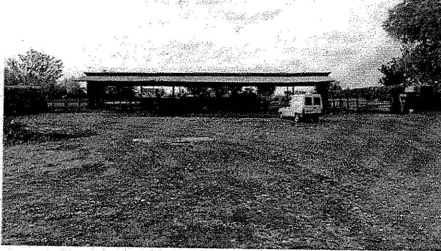
Fabbricato "E" - Vista prospetto nord
