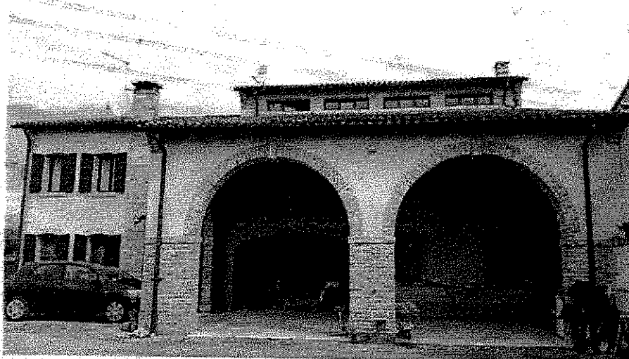
Vista prospetto sud - porticato d'ingresso
