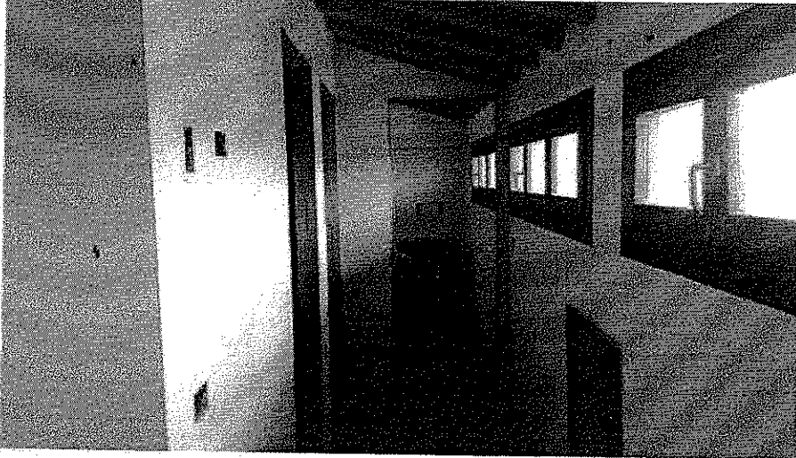
Piano secondo - Corridoio
