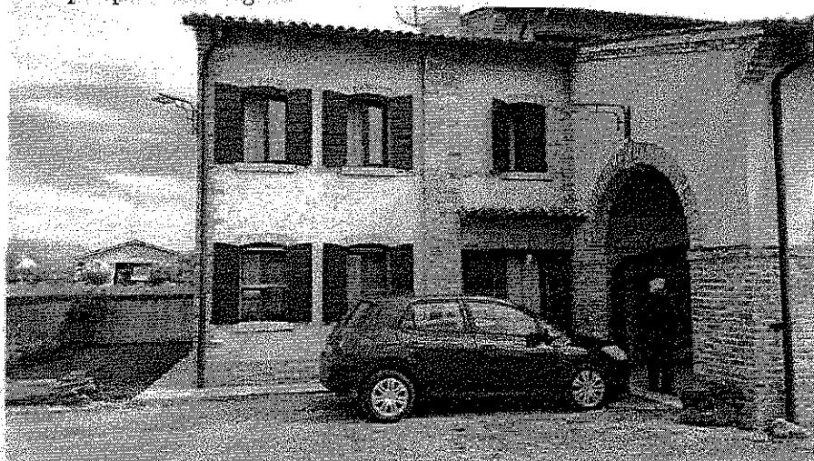
Vista prospetto sud - ingresso
