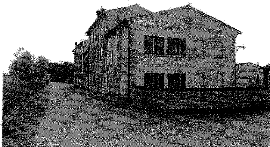
Vista prospetto ovest
