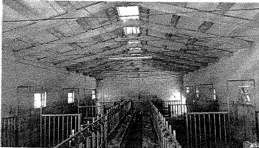
Fabbricato "B" - Vista interna
