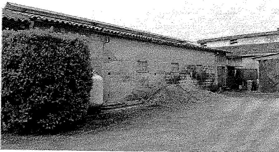
Fabbricato "B" - Vista prospetto nord
