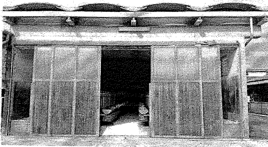
Fabbricato "C" - Vista lato est.
