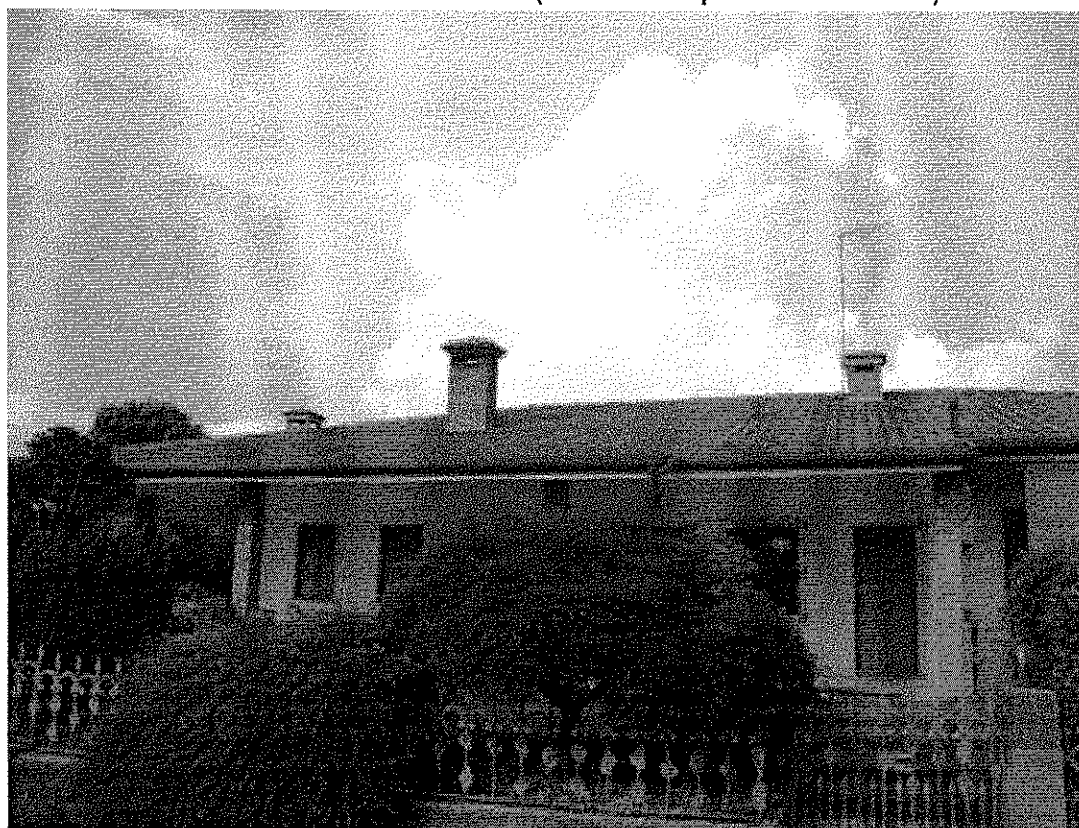
Foto 13 – vista lato ovest (con accesso pedonale civico 6/A)
