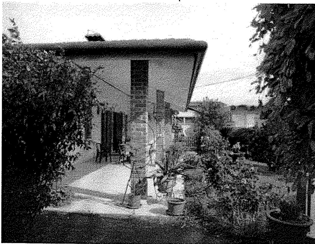
Foto 14 – vista da nord del portico lato ovest
