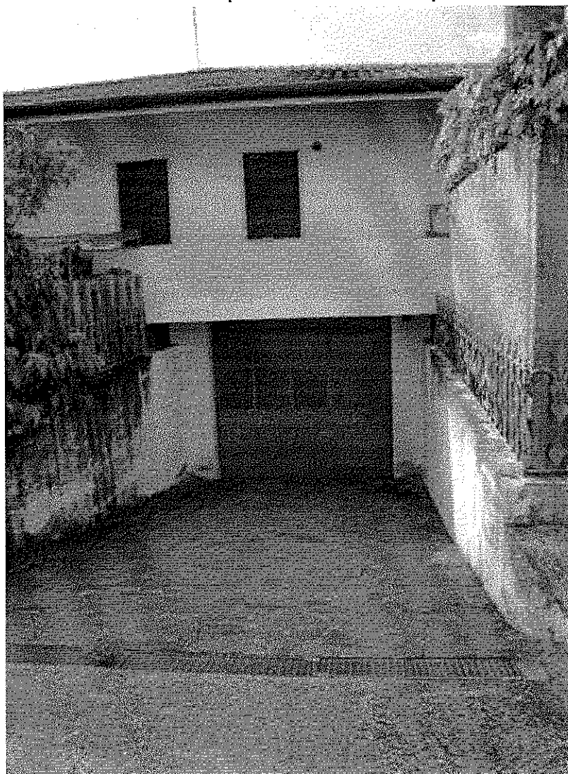
Foto 19 – vista della rampa carraia di accesso al piano interrato
