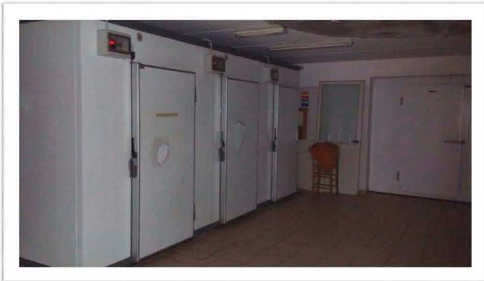
ZONA CONSERVAZIONE ALIMENTI (CELLE FRIGORIFERE)
