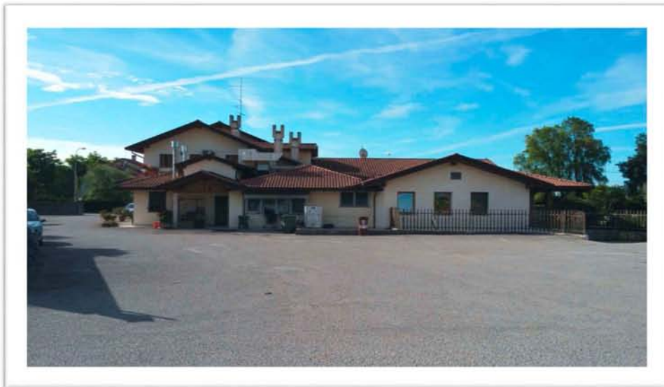
VISTA FABBRICATO PROSPETTO DA ACCESSO PARCHEGGIO
