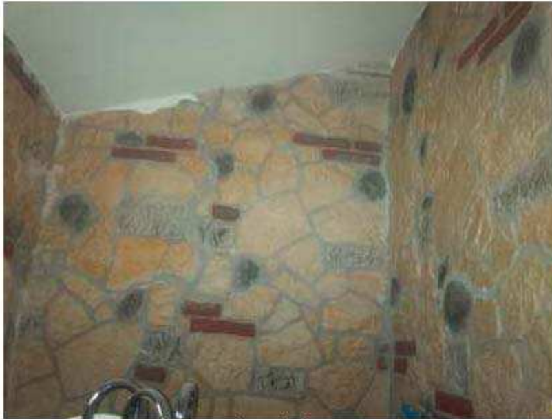
Foto n. 21 - Locale cantina. Dettaglio del rivestimento.
