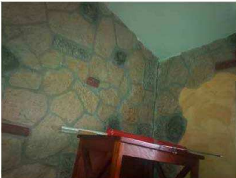
Foto n. 22 - Locale cantina. Dettaglio del rivestimento.
