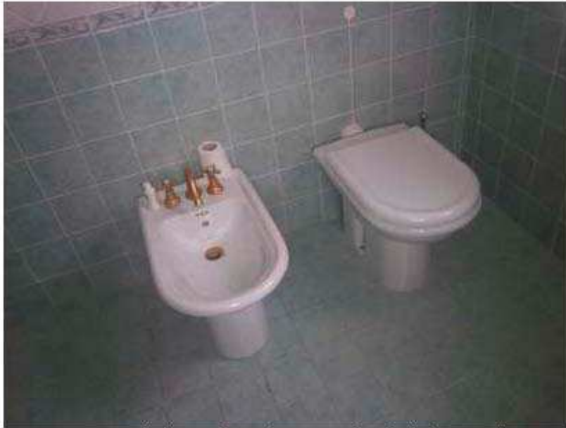
Foto n. 35 - Bagno principale al piano primo: dettaglio sanitari di water e bidet.
