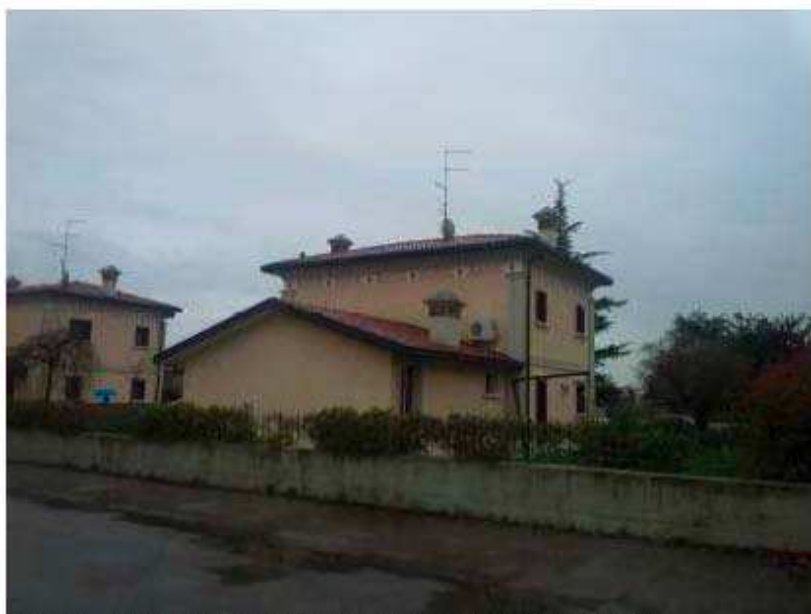
Foto n. 4 – Abitazione con autorimessa in visione prospettica da nord.
