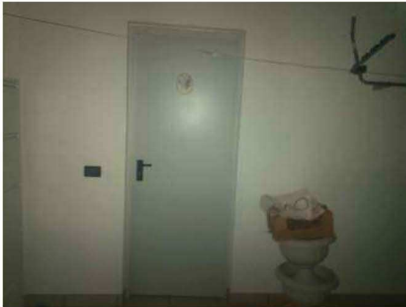
Foto n. 23 - Porta in metallo di accesso alla cantina.
