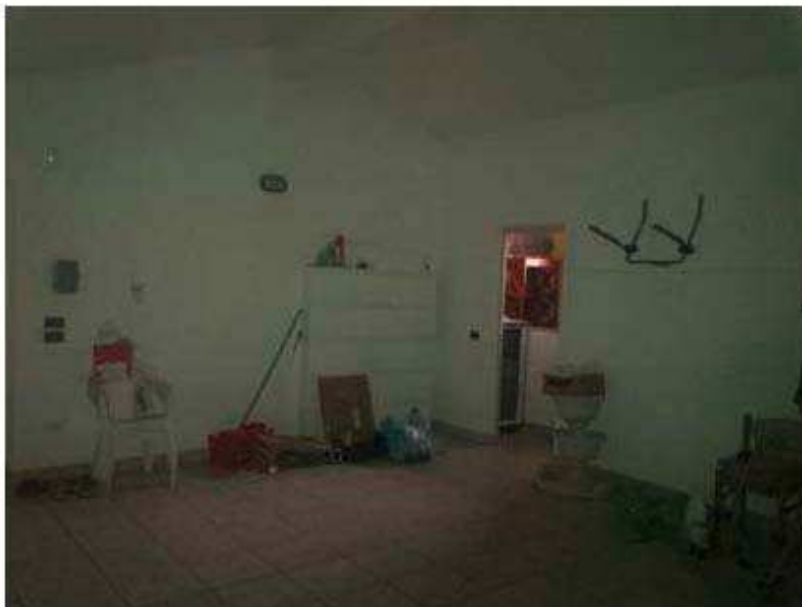
Foto n. 42 – Autorimessa: interno con in fondo accesso alla cantina.
