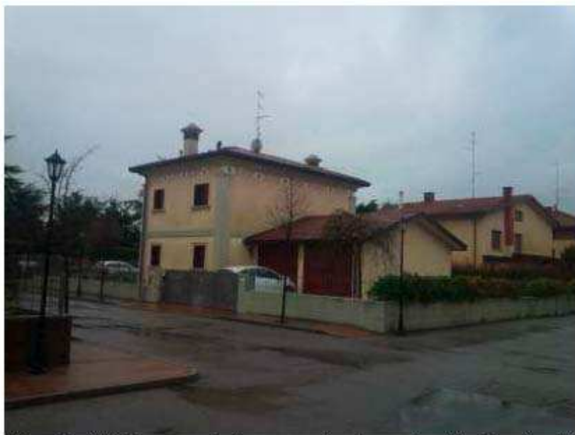
Foto n. 3 – Abitazione con autorimessa oggetto di esecuzione (in primo piano) in visione prospettica da nord - est.
