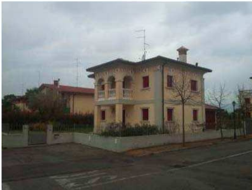
Foto n. 2 - Abitazione con autorimessa oggetto di esecuzione (in primo piano) in visione prospettica da sud est.
