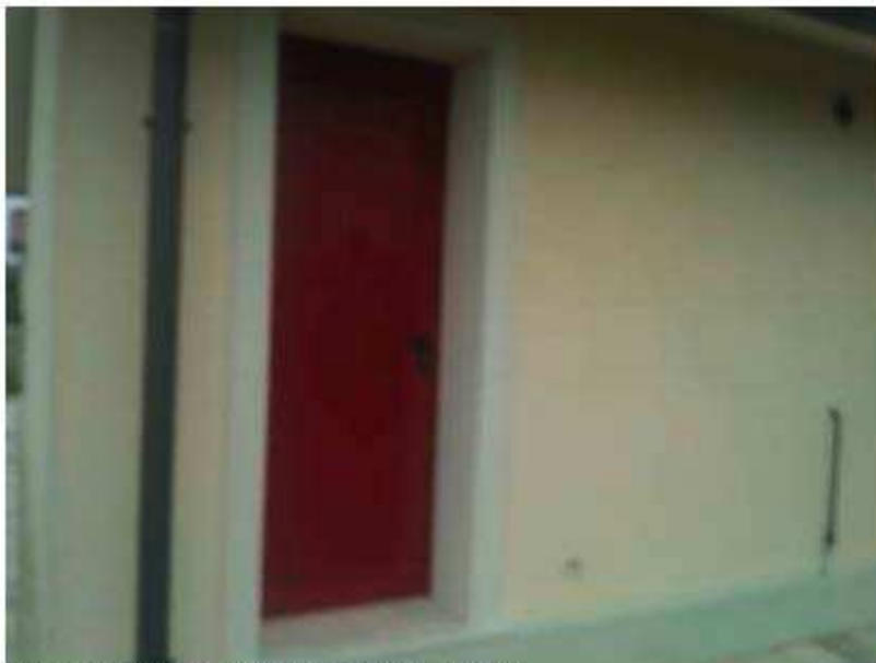
Foto n. 20 - Porta di accesso alla centrale tecnica.
