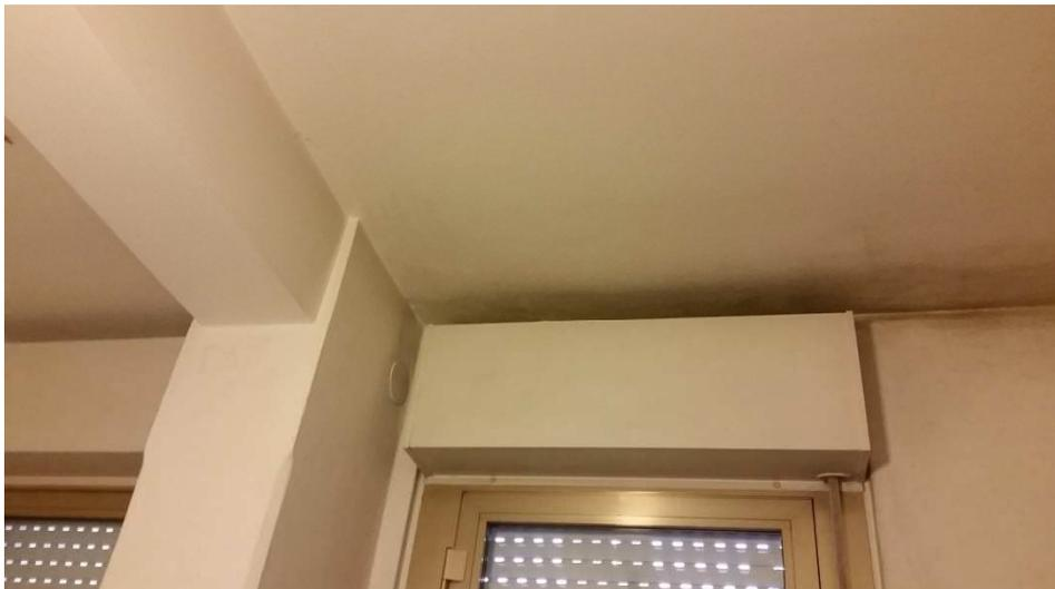
Tracce di muffa dovute probabilmente a ponte termico nella camera da letto che da sulla terrazza
