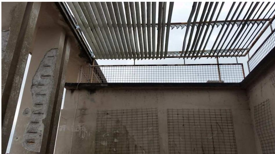
Copertura in frangisole della terrazza alla quale si accede dalla sala. Si noti anche il livello di degrado delle colonne.
