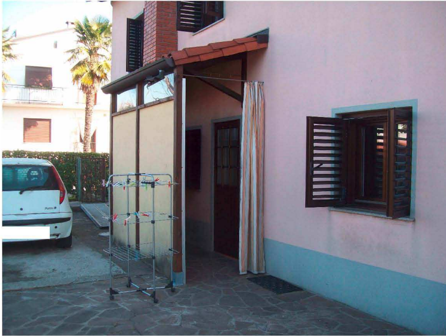
Foto 5: Particolare bussola prospetto Ovest
