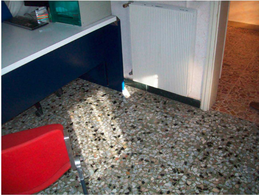
Foto 15: Pavimenti piano primo
