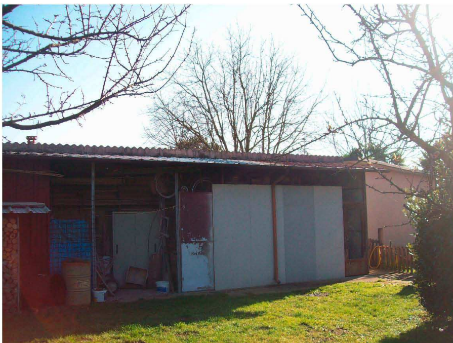
Foto 29: Prospetto Ovest annesso
