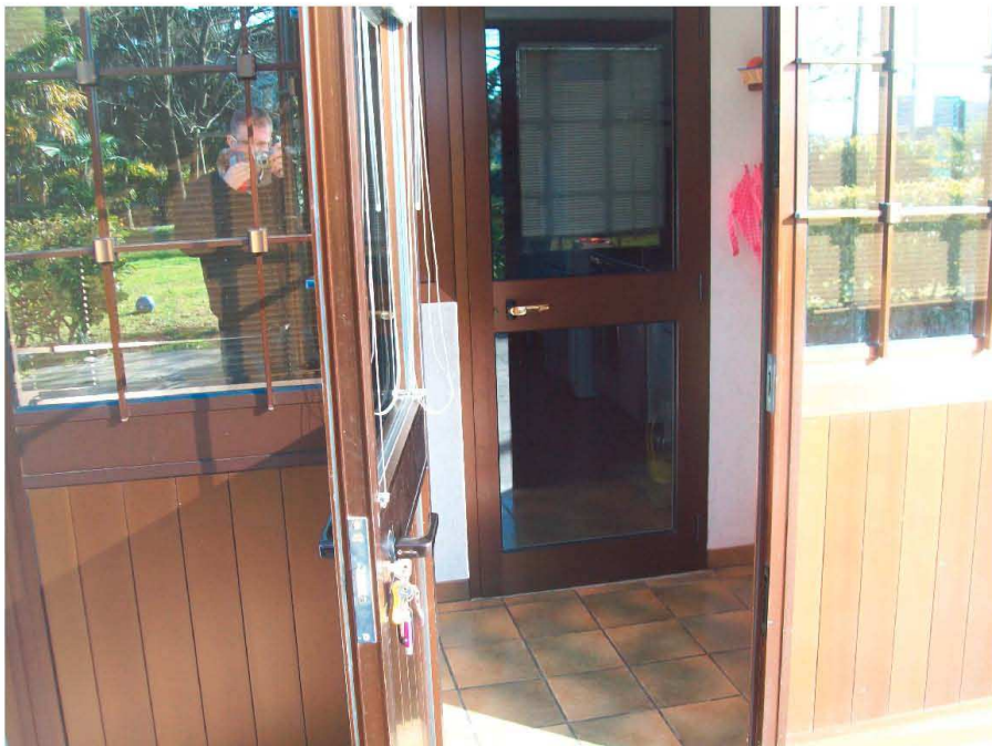
Foto 6: Particolare ingresso Sud piano terra
