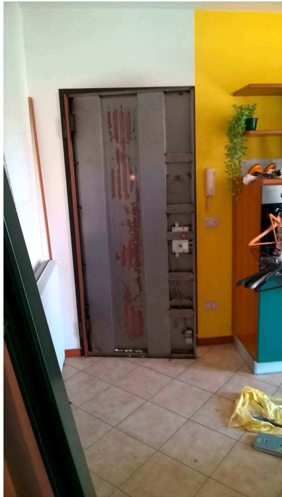
porta ingresso smontaggio e cambio serratura
