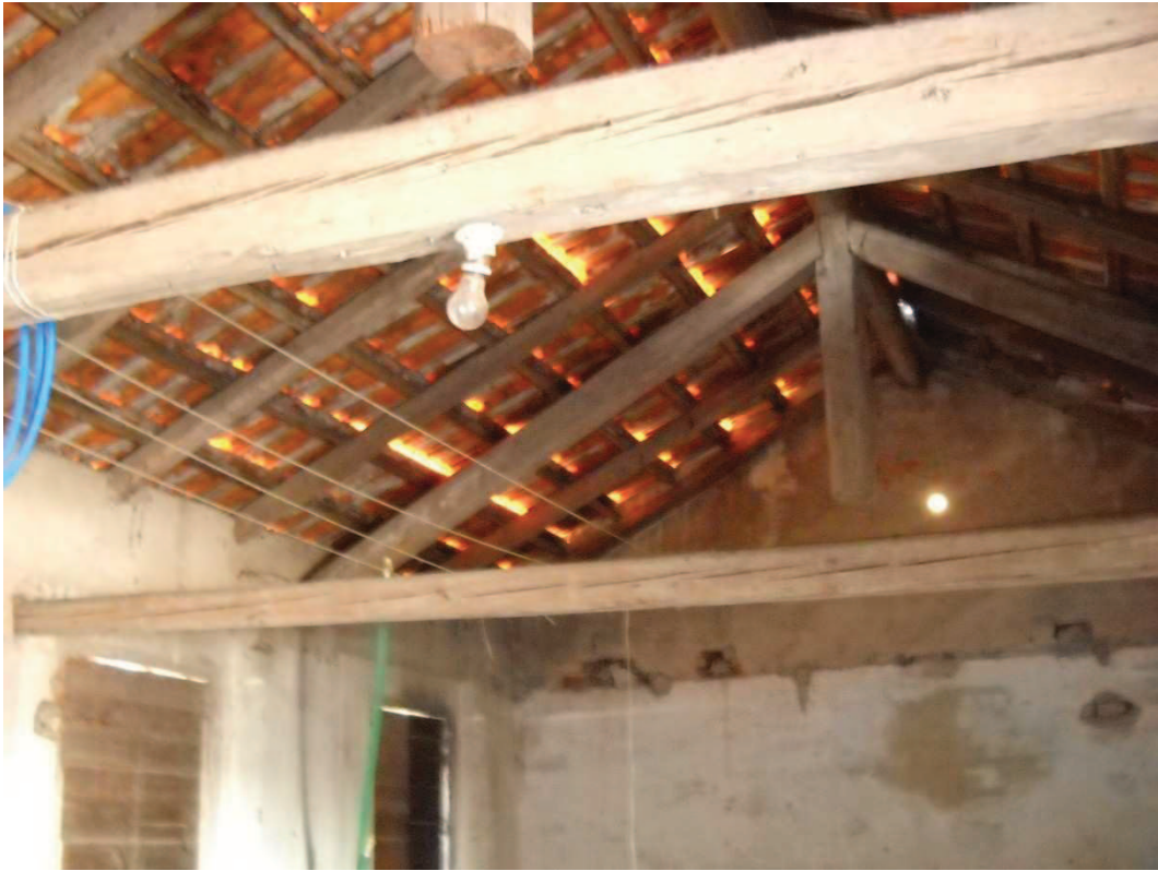
Foto 22 soffitta – particolare tetto
