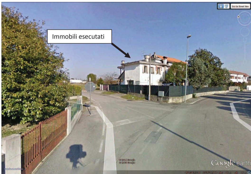
Foto 7 Esterno immobili_ Lotto 2 oggetto di esecuzione
