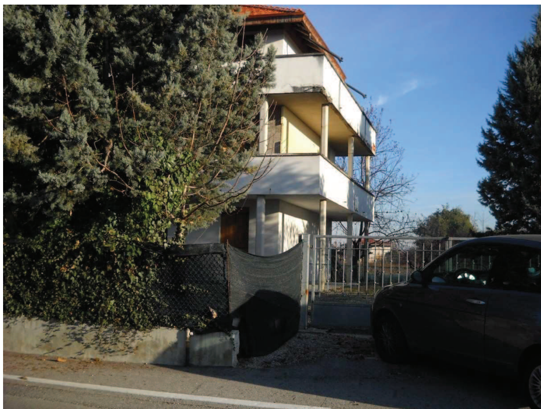
Foto 8 accesso immobile da Via U. Foscolo
