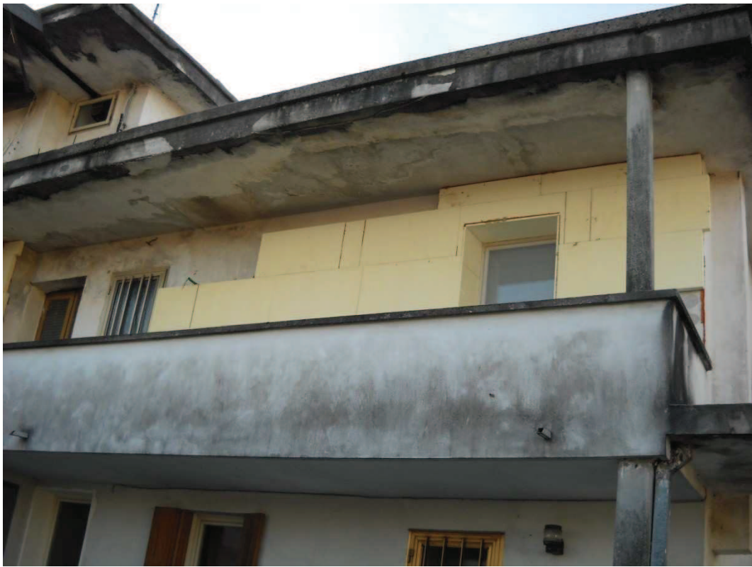
Foto 11 Stato lavori per realizzazione cappotto esterno
