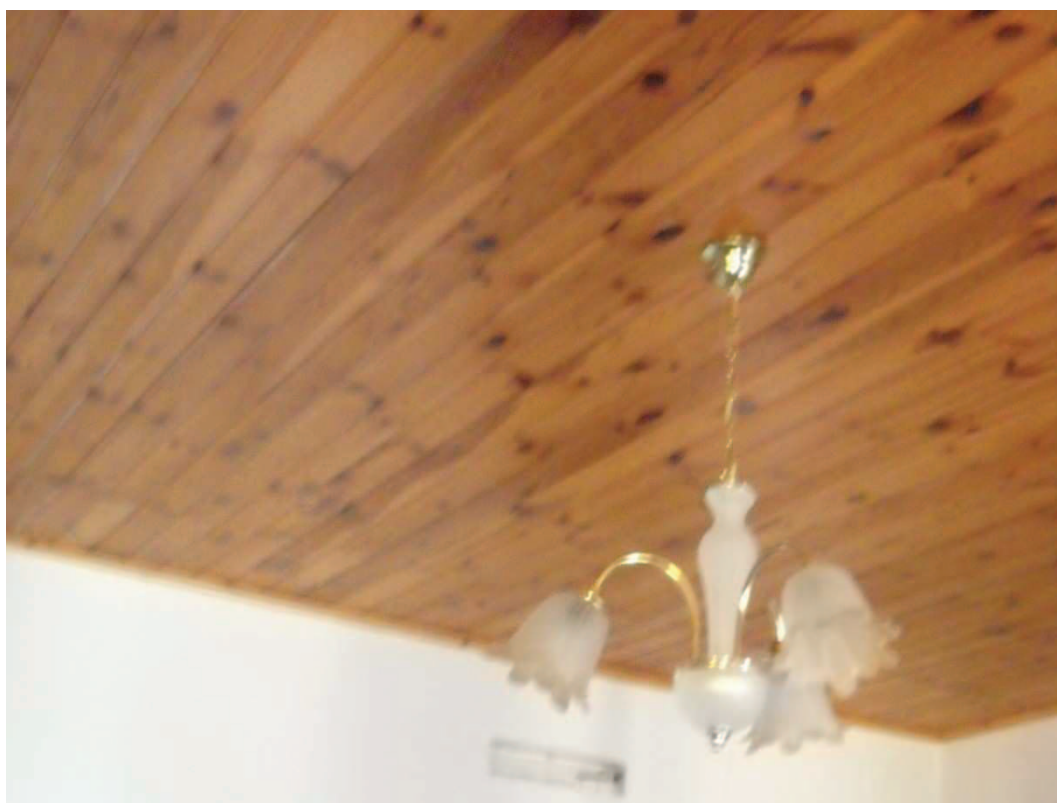
Foto 14 Dettaglio soffitto perlinato
