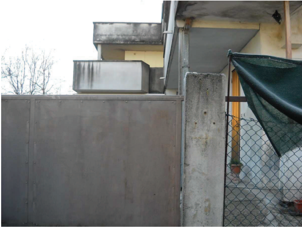
Foto 9 accesso immobile da Via Mascagni
