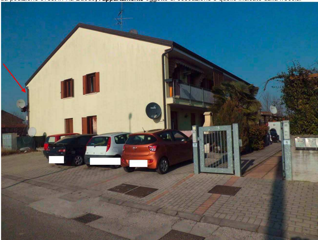
Foto n° 2 - 19/02/2015 - Comune di Pravisdomini - Foglio 11 part. 495 - Veduta generale del condominio da posizione sud in via Buodo. Visibile il portoncino d'accesso al vialetto interno che divide il complesso condominiale.
