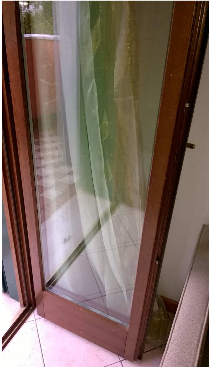
dettaglio serramento sala sul terrazzo
