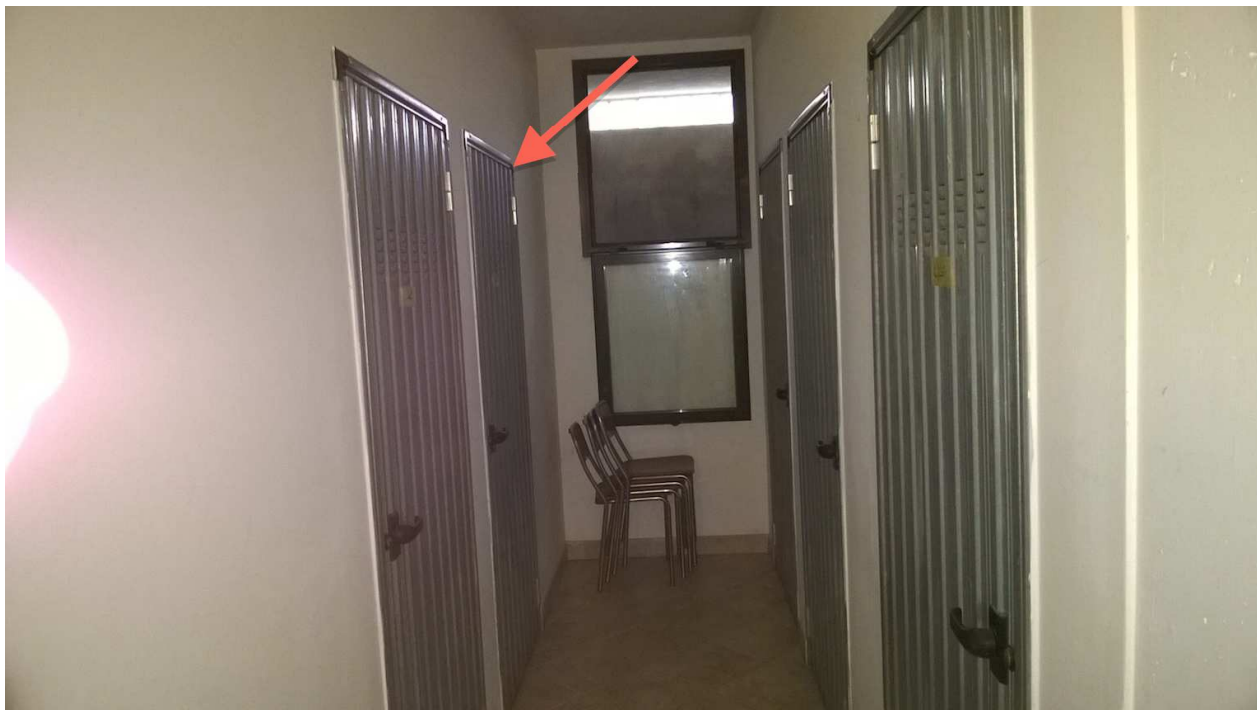
cantina al piano interrato
