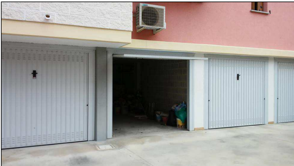
Fig.34: vista esterna garage con accesso da ampio spazio di manovra
