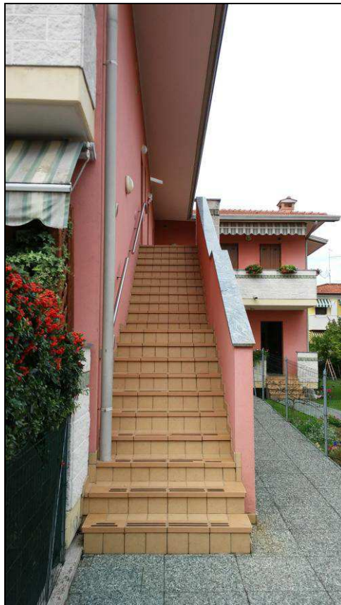
Fig.4: vista scalinata d'ingresso comune
