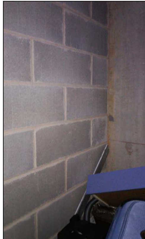
Fig.32: particolare muratura in blocchi Leca cantina
