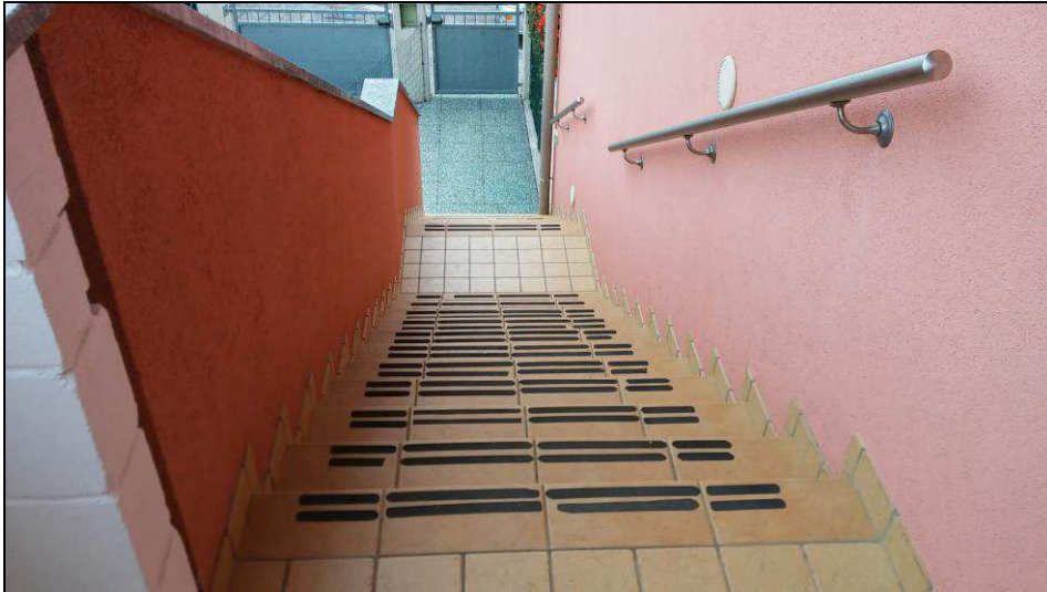
Fig.5: vista scalinata d'ingresso dall'alto
