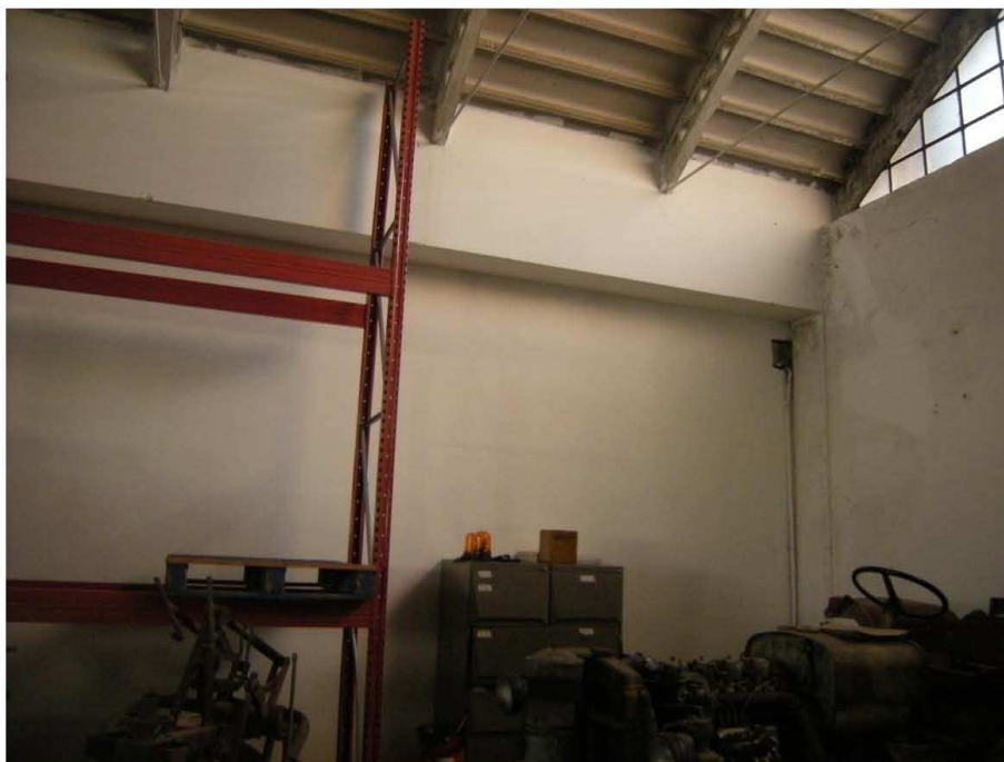
Prata di Pordenone, Particella 629 – Il Capannone, sotto la parete a sud-est.
