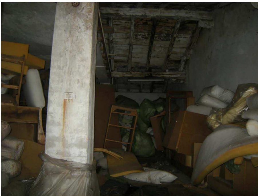
Prata di Pordenone, Particella 629 – L'immobile al piano primo con destinazione d'uso ripostiglio n° 2.
