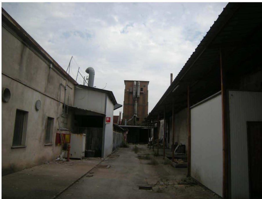
Prata di Pordenone, Particella 629 – Il Silos e la strada di accesso ad esso.
