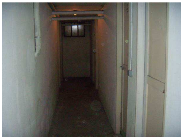
Corridoio di accesso alla cantina posta al piano interrato
