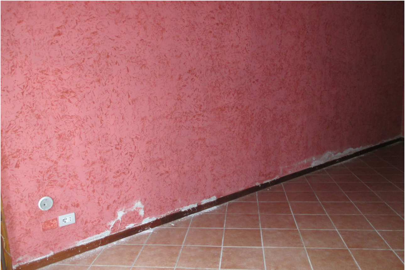
dettaglio piano terra
