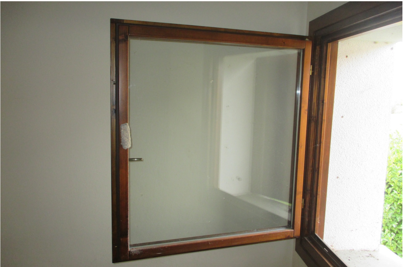
dettaglio finestra piano 1°
