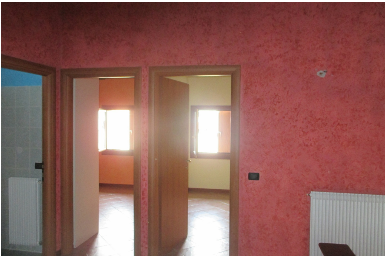
vista interna piano 1°
