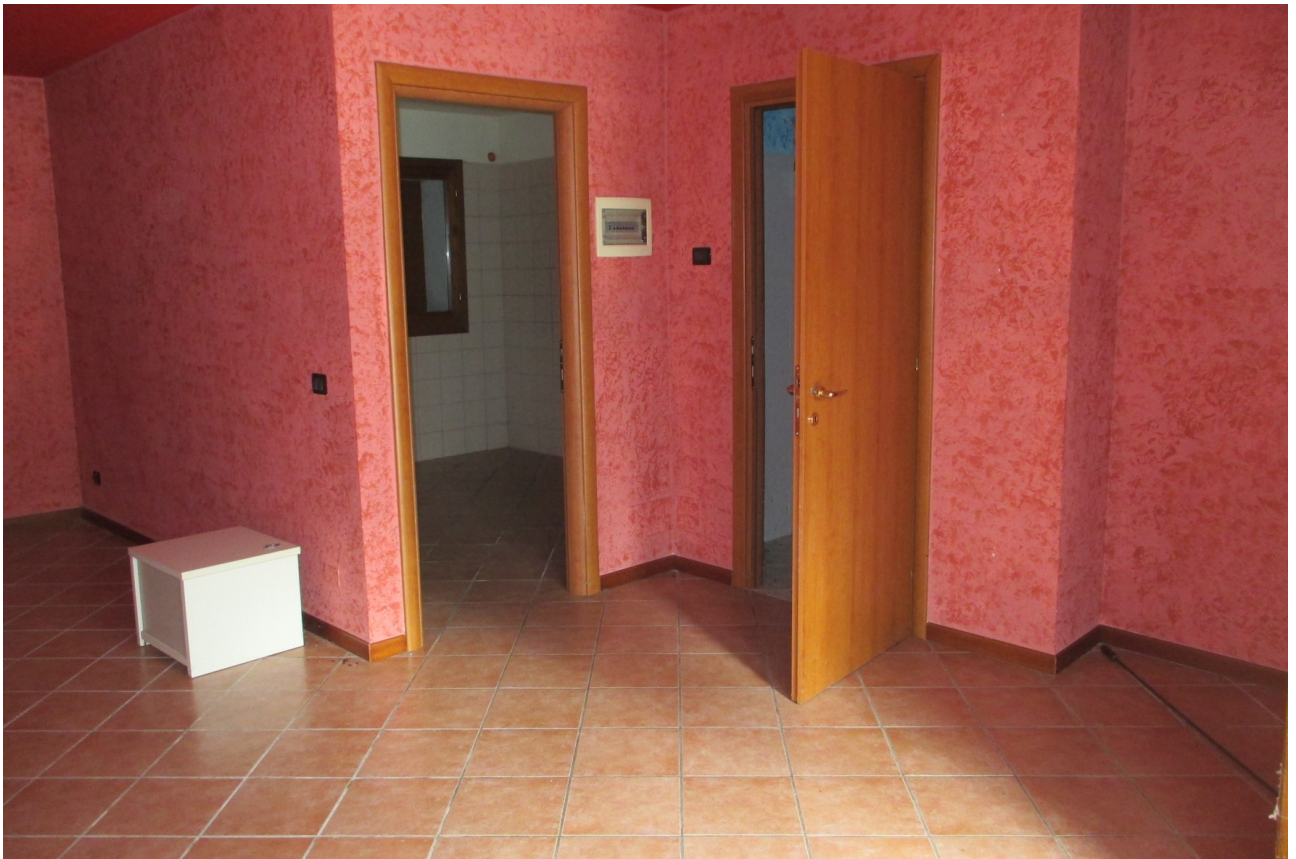
interno piano terra
