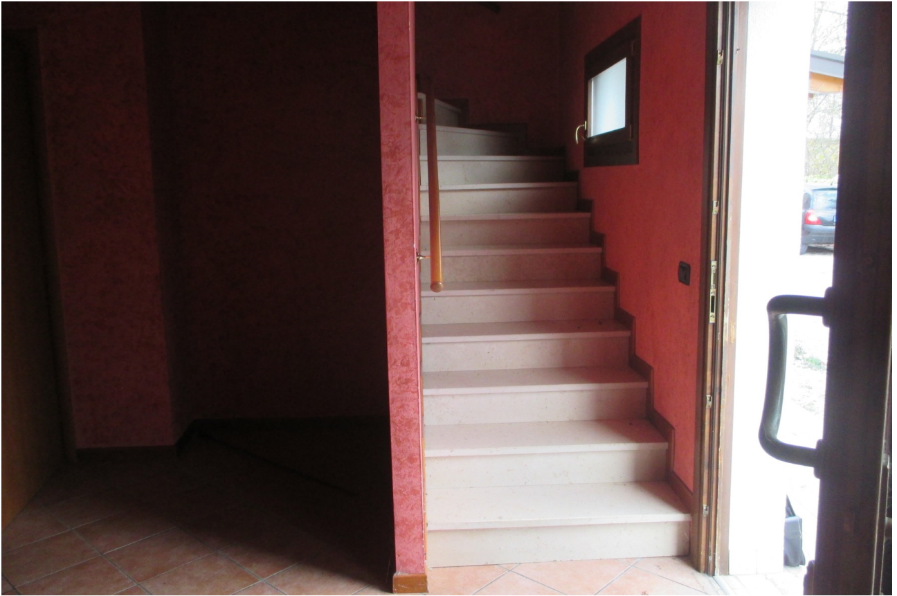
interno piano terra
