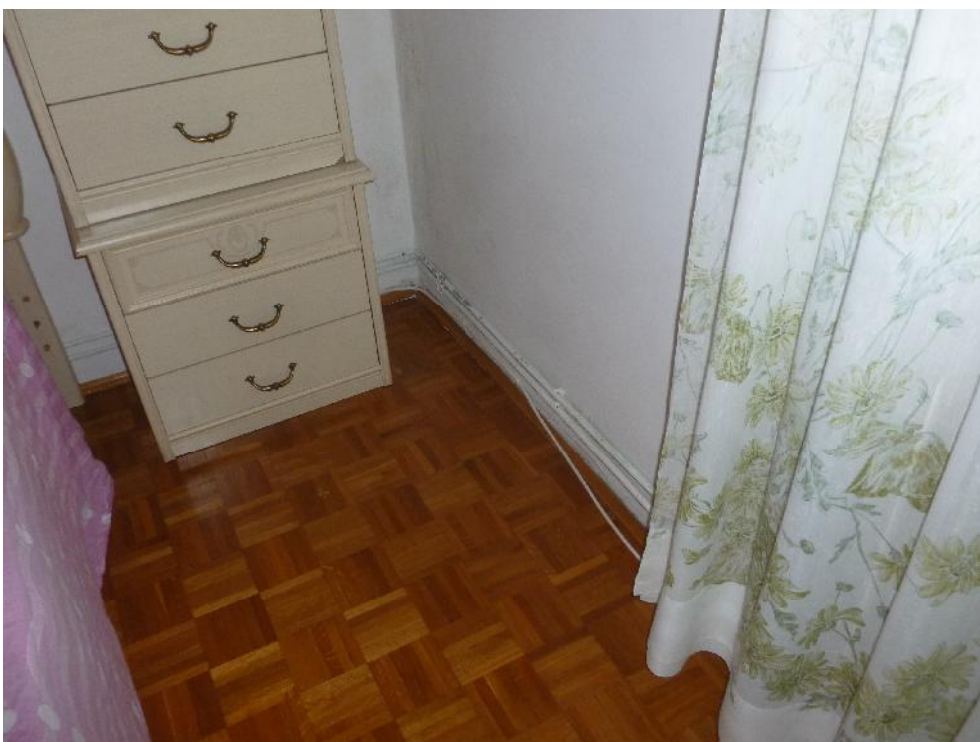
Foto n. 12 – Camera n. 3 con dettaglio della pavimentazione.
