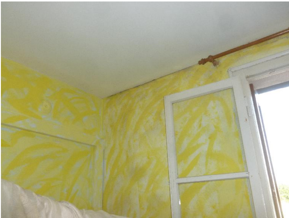
Foto n. 11 – Camera n. 2 dettagli del serramento della finestra.
