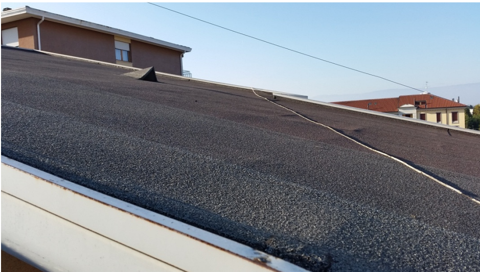
Foto della copertura
