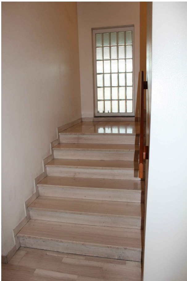
Foto n. 5 – vano scale condominiale
