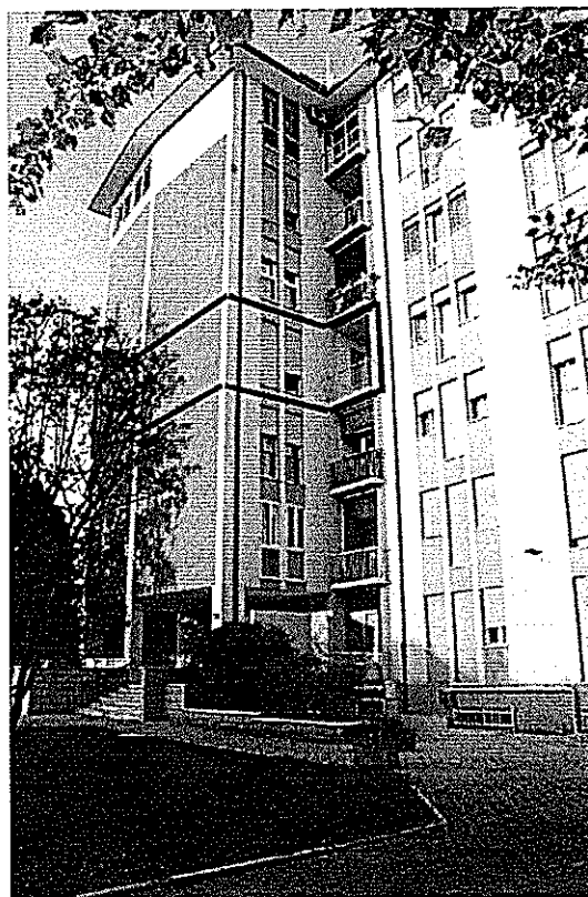
Foto n. 2 - prospetto sud fabbricato condominiale
