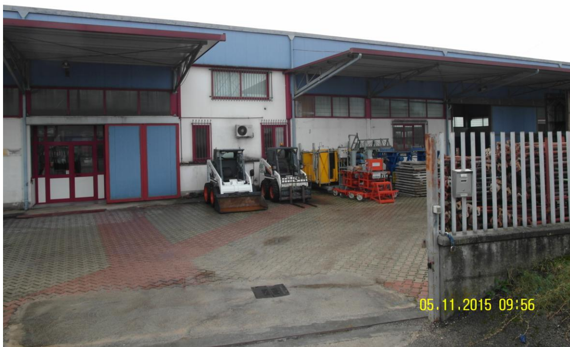
Foto n. 2: Accesso al fabbricato dal lato Nord ove è presente un ampio parcheggio sopraelevato.
