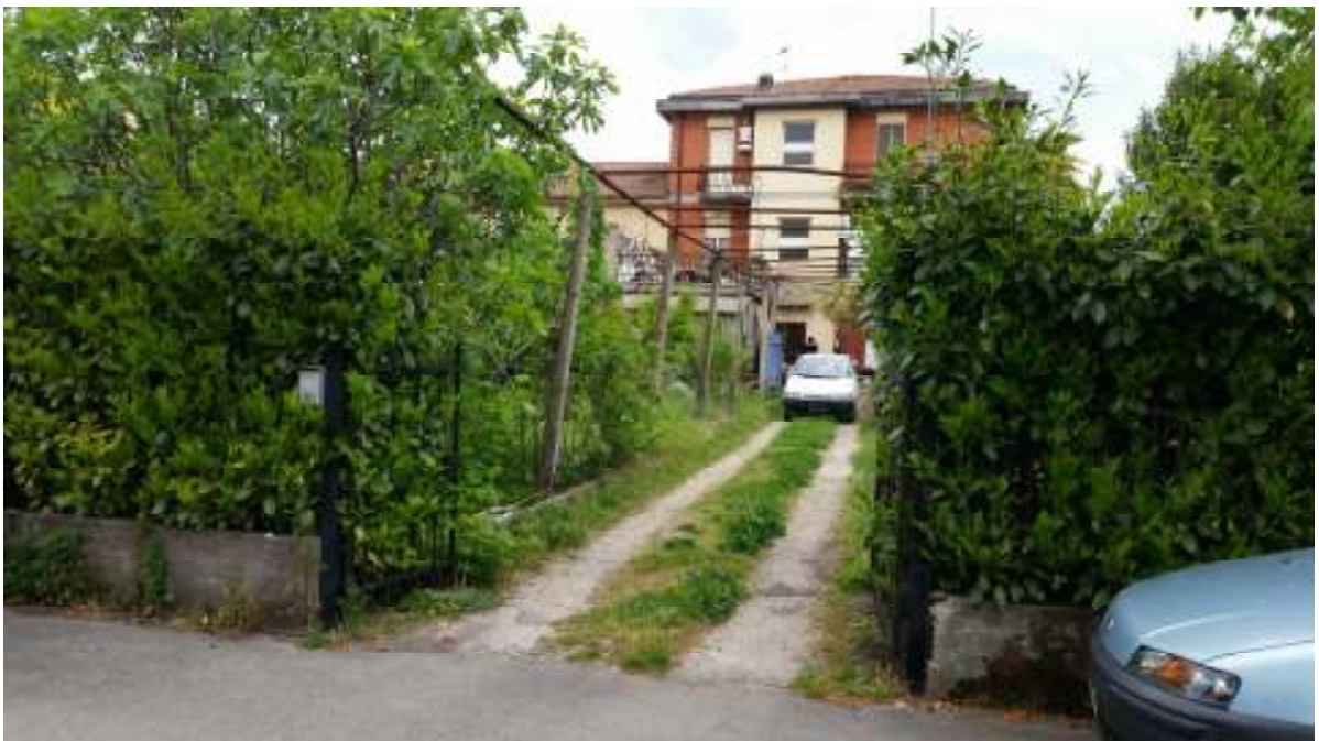
esterno fabbricato - da via della Libertà (accesso carrabile con cancello)
