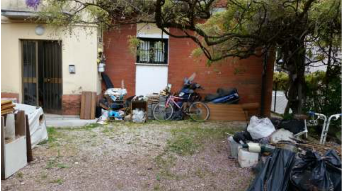
esterno fabbricato - accesso al vano scala comune
