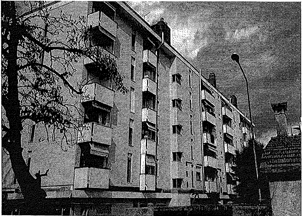
Foto 11 – vista del prospetto sud del condominio di cui sono parte le unità in oggetto l'appartamento al piano primo oggetto di esecuzione è individuato con tratteggio rosso
