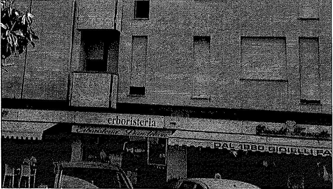
Foto 10 – particolare del prospetto nord dell'appartamento al piano primo oggetto di esecuzione
