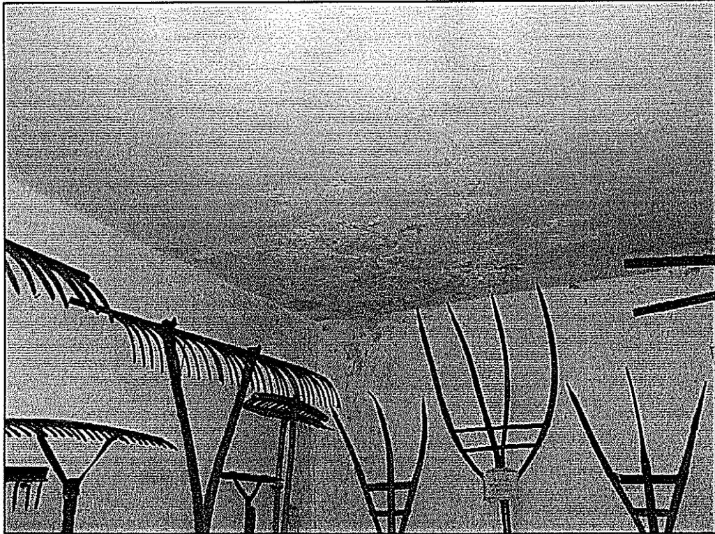
Foto 19: danni causati dall'infiltrazioni d'acqua
