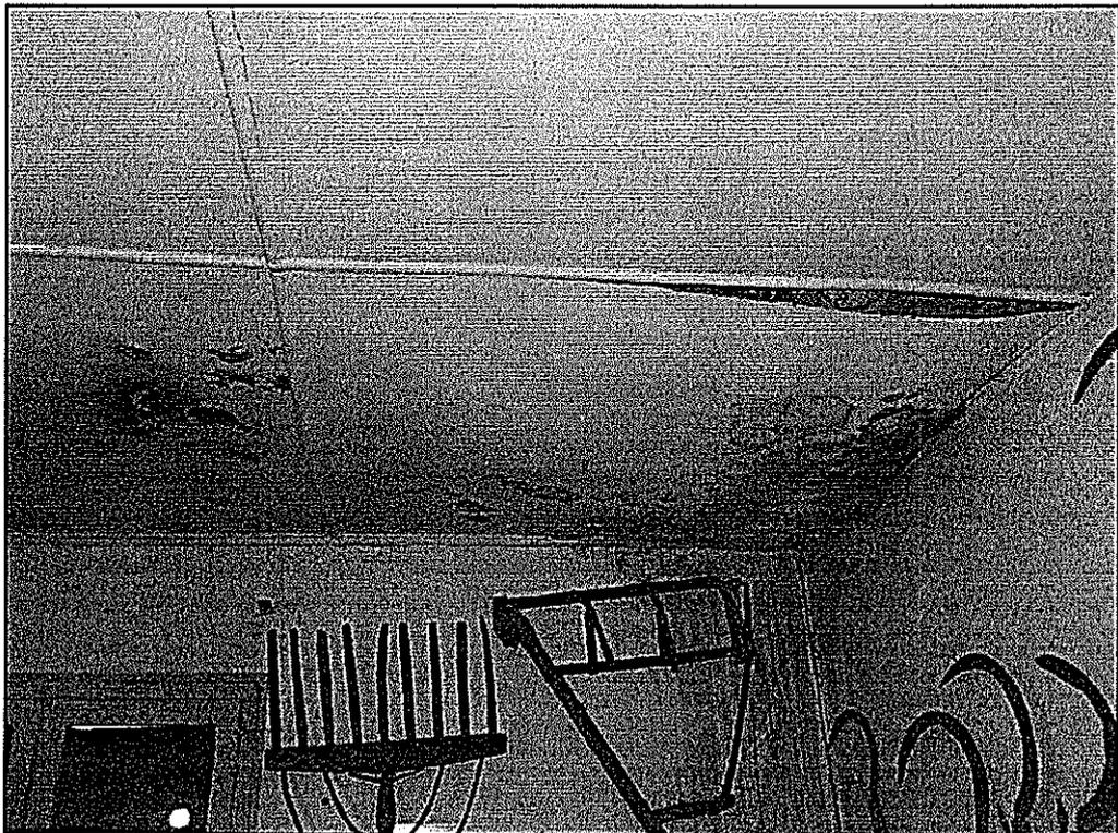
Foto 20: danni causati dall'infiltrazioni d'acqua
