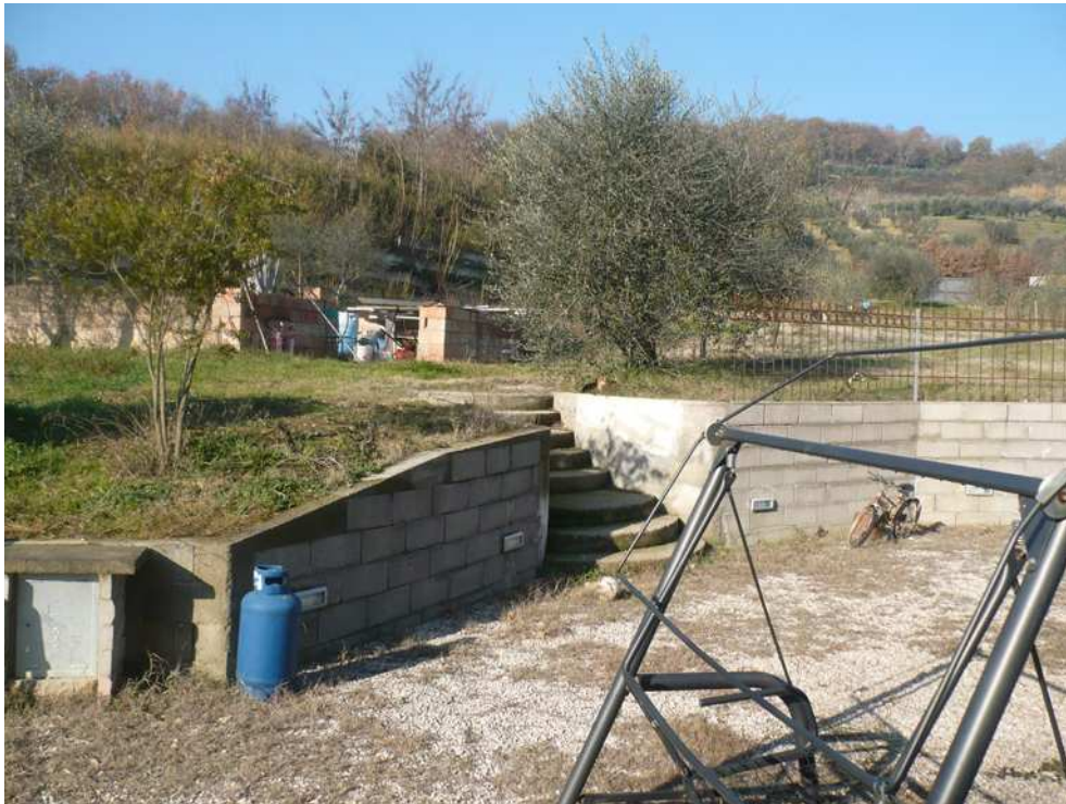
Vista della sistemazione esterna: scale – muretto di contenimento terreno
